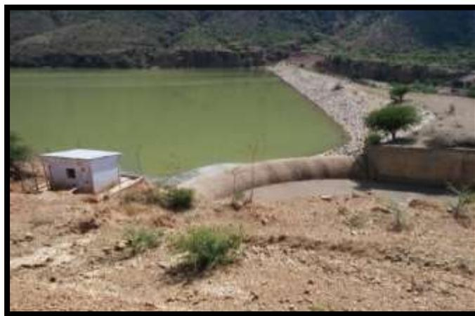
La sección vertedera clasificada por su disposición en planta, como aliviadero curvo en planta más propiamente como aliviadero semi-abanico, fue construida con un perfil
