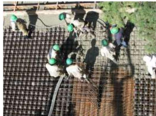
Inclusión de las tuberías dentro de la losa, instalaciones eléctricas, sanitaria, y losa radiante.
