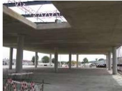
El comportamiento estructural y el método de cálculo usado para las losas Prenova es idéntico al de una losa maciza.
