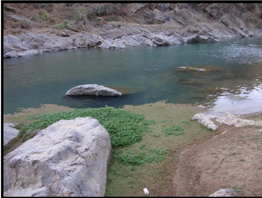
Fotografía 3. Interceptor del angosto de Tomatitas, contaminando el río Guadalquivir.
