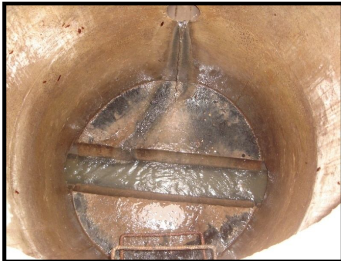
Fotografía 2. Cámara de inspección
