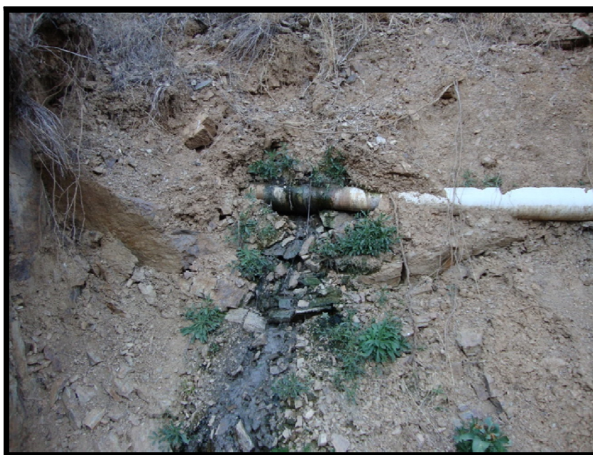
Fotografía 1. Ruptura del Interceptor del angosto de Tomatitas
