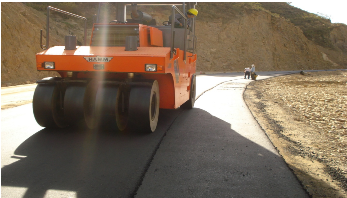
Compactación de la carpeta asfáltica
