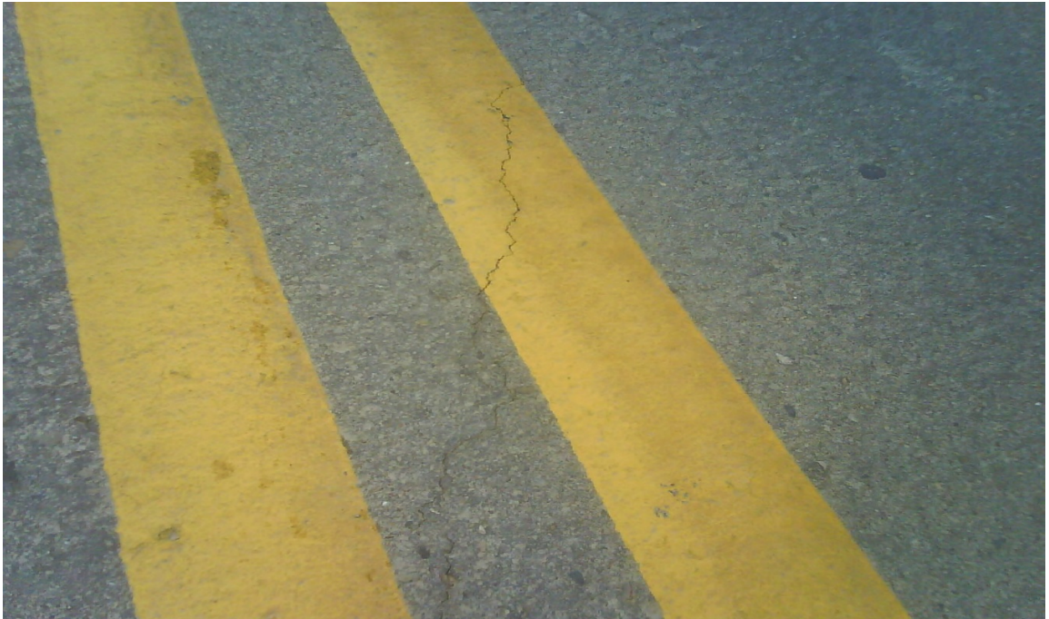
Fisura longitudinal
