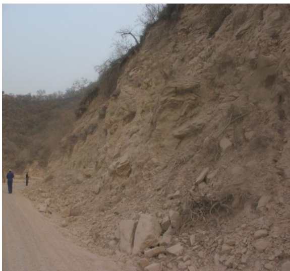
Talud “A”, ubicado en la progresiva 70 + 000 talud de estudio
