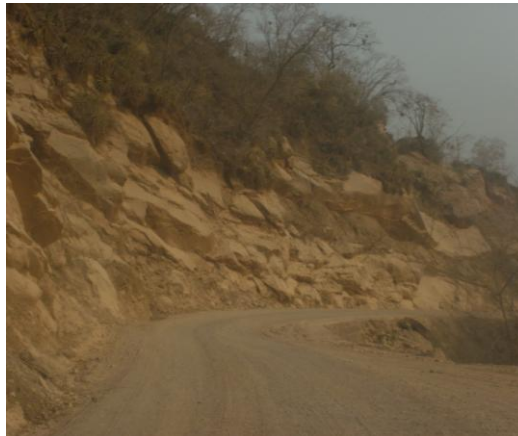
Talud "F", ubicado en la progresiva 46 + 231
