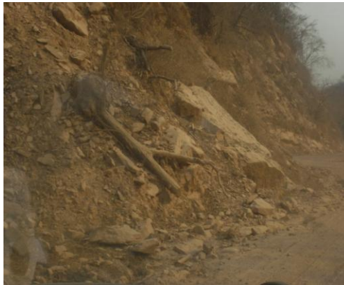
Talud "E", ubicado en la progresiva 47+ 217
