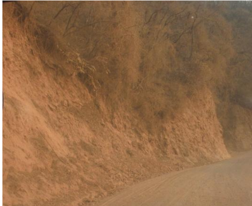
Talud “B”, ubicado en la progresiva 61+082
