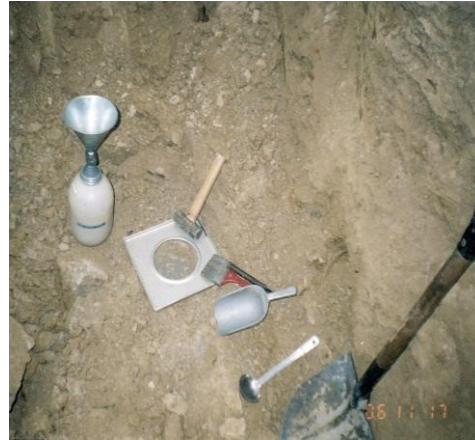
Ensayo de la Densidad in situ en la Progresiva 70 + 000
