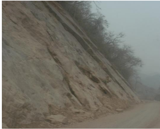
Talud "G", ubicado en la progresiva 45+ 750
