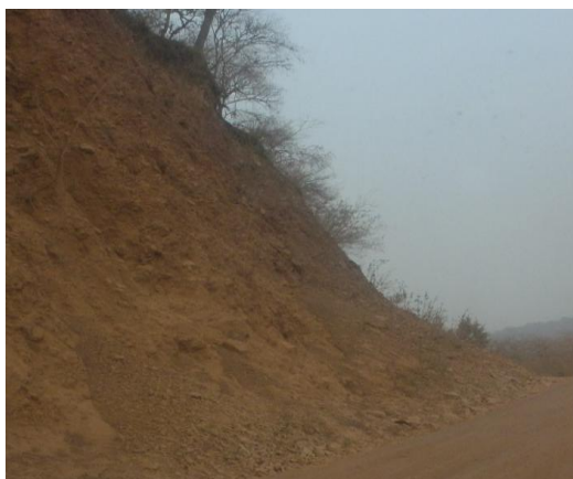
Talud “C”, ubicado en la progresiva 59+000
