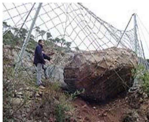
Rocas de gran tamaño soportadas por barreras dinámicas
