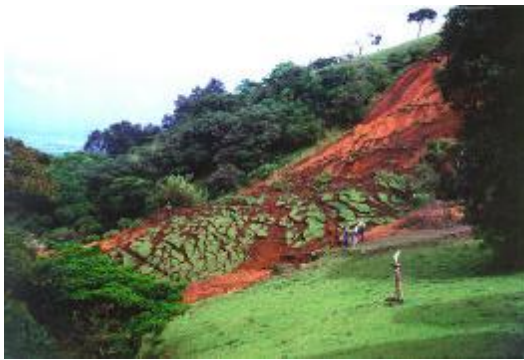
Material desplazado en estado deformado
