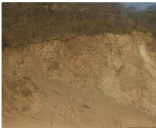
Talud “K”, ubicado en la progresiva 27+ 500
