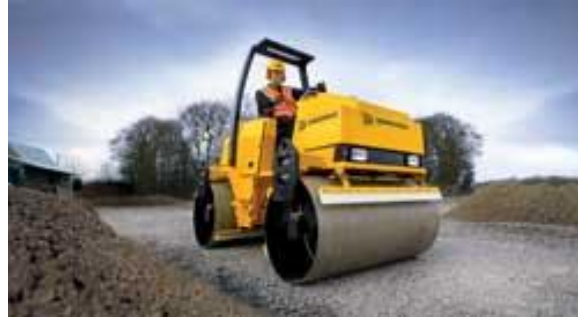
Fig. 2.11 Compactación con maquinaria
