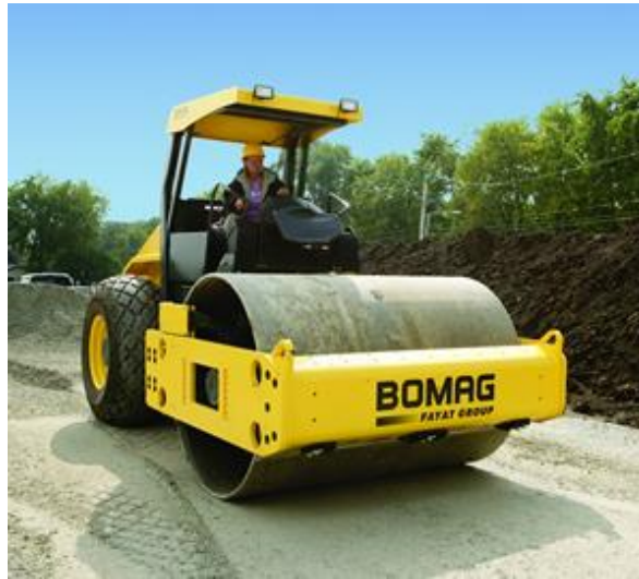
Fig. 2.16 Compactación con rodillo vibratorio
