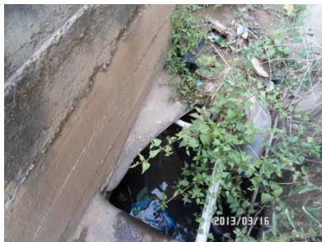
Entrada de la alcantarilla
