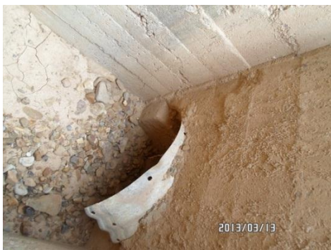
Entrada de la alcantarilla
