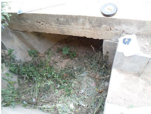
Entrada de la alcantarilla
