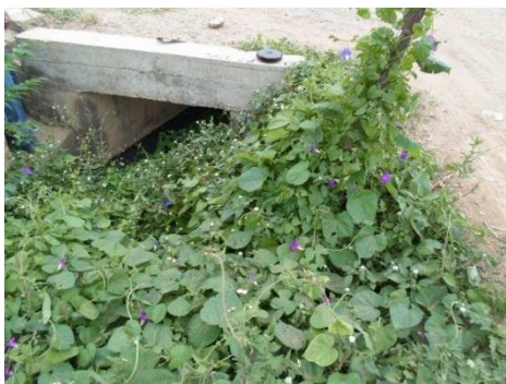
Entrada de la alcantarilla
