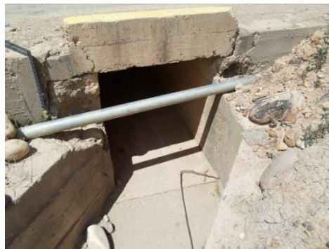
Salida de la alcantarilla
