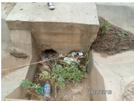
Entrada de la alcantarilla
