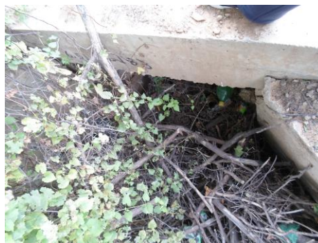
Salida de la alcantarilla
