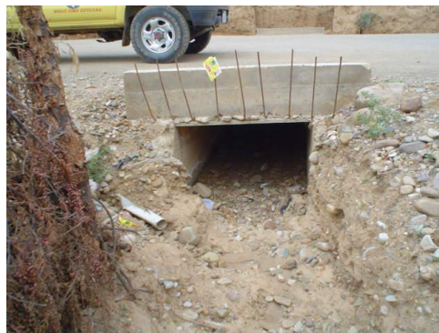
Salida de la alcantarilla
