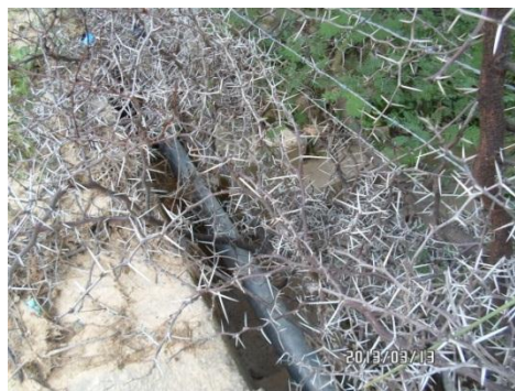
Salida de la alcantarilla
