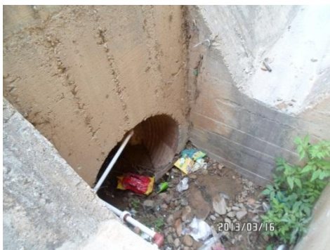
Entrada de la alcantarilla
