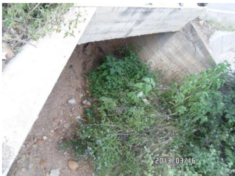
Entrada de la alcantarilla
