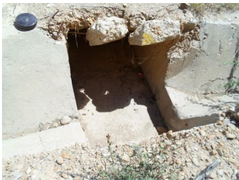
Entrada de la alcantarilla
