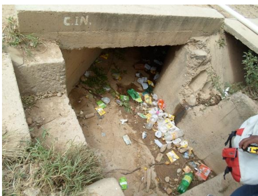
Entrada de la alcantarilla
