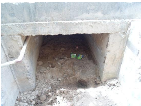
Entrada de la alcantarilla
