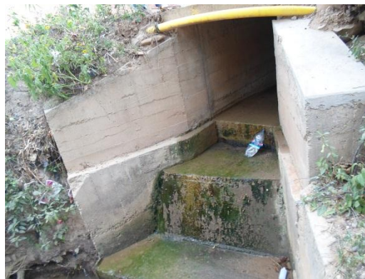
Salida de la alcantarilla
