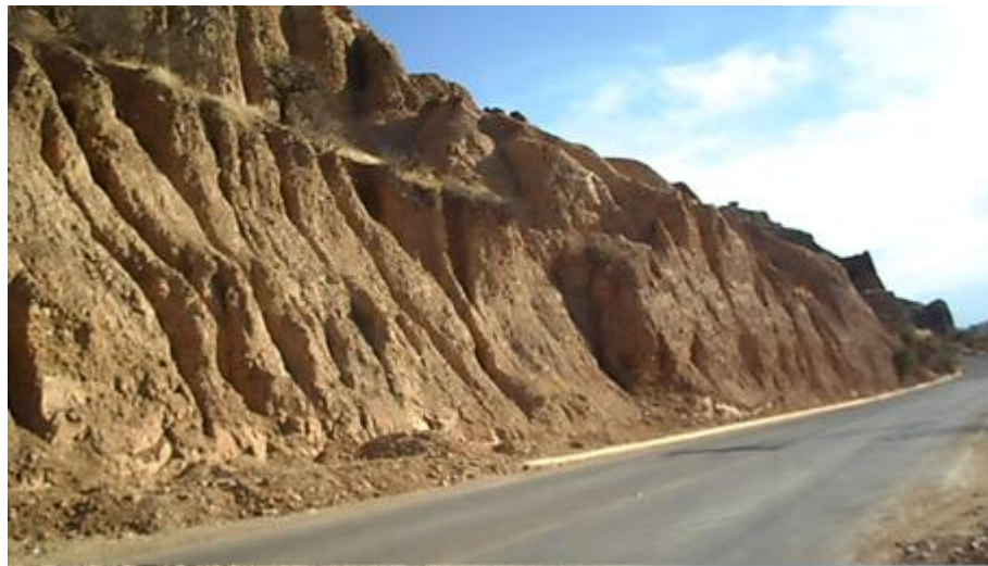
Fotografía 5.3 Talud 1 antes de las lluvias.
