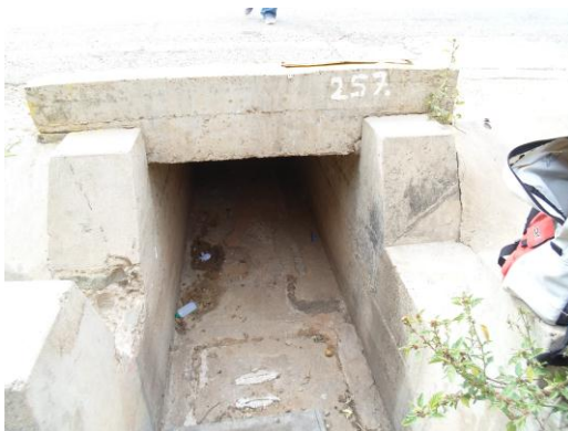
Entrada de la alcantarilla
