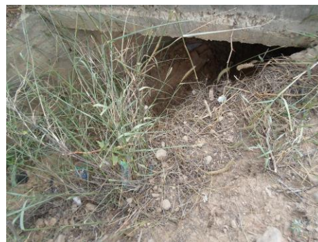
Salida de la alcantarilla
