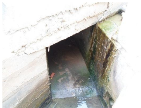
Salida de la alcantarilla
