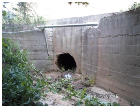
Salida de la alcantarilla
