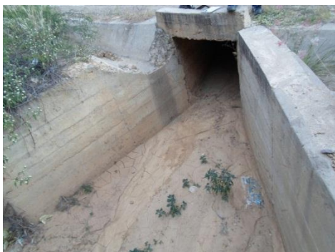
Entrada de la alcantarilla
