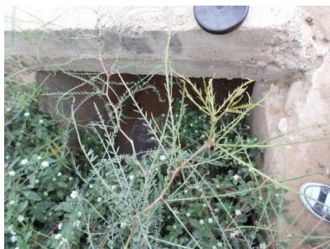
Entrada de la alcantarilla
