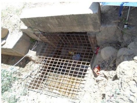
Entrada de la alcantarilla
