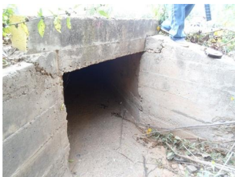
Entrada de la alcantarilla
