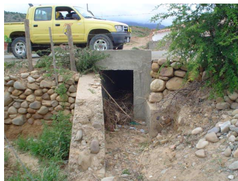
Salida de la alcantarilla
