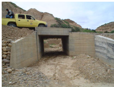
Salida de la alcantarilla
