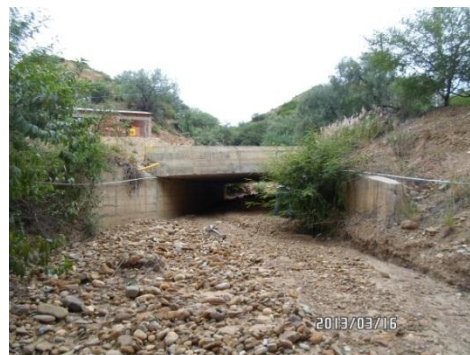
Salida de la alcantarilla
