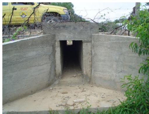
Salida de la alcantarilla
