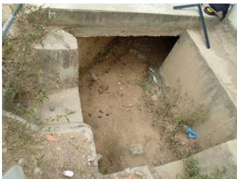
Entrada de la alcantarilla
