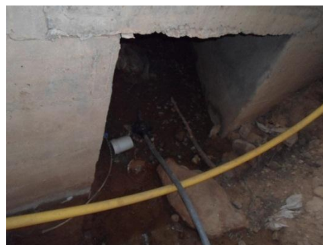
Salida de la alcantarilla
