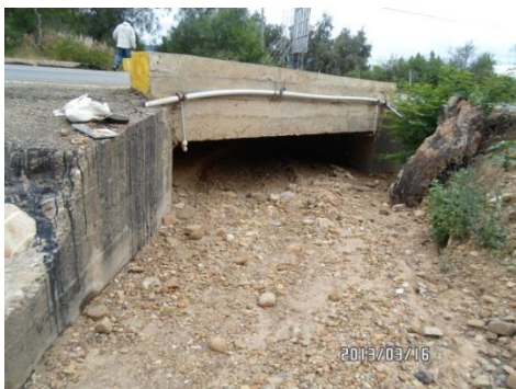
Entrada de la alcantarilla
