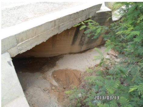
Entrada de la alcantarilla
