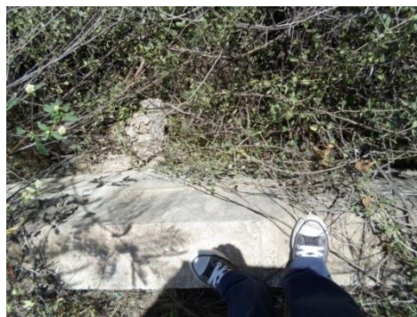
Salida de la alcantarilla
