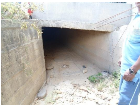
Entrada de la alcantarilla
