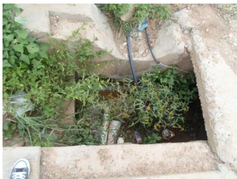
Entrada de la alcantarilla
