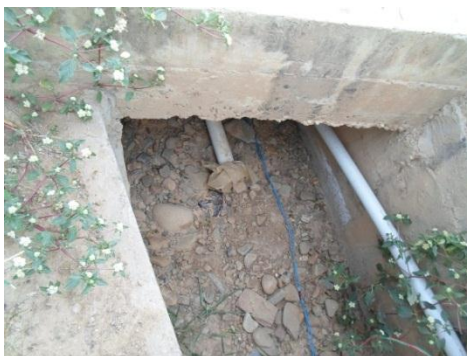
Salida de la alcantarilla
