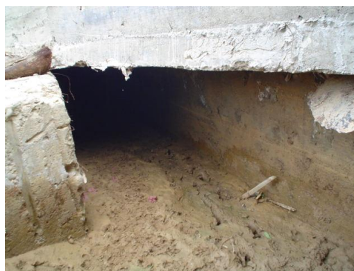
Salida de la alcantarilla
