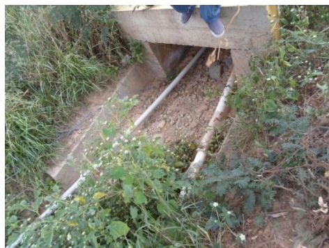
Entrada de la alcantarilla
