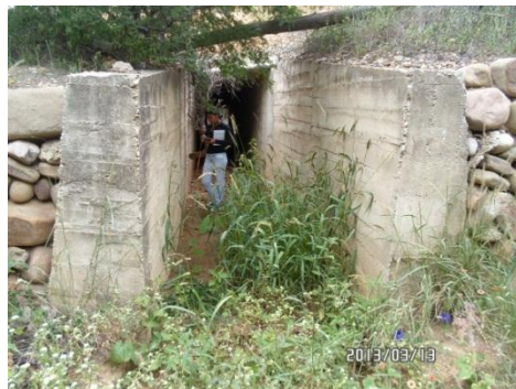
Salida de la alcantarilla
