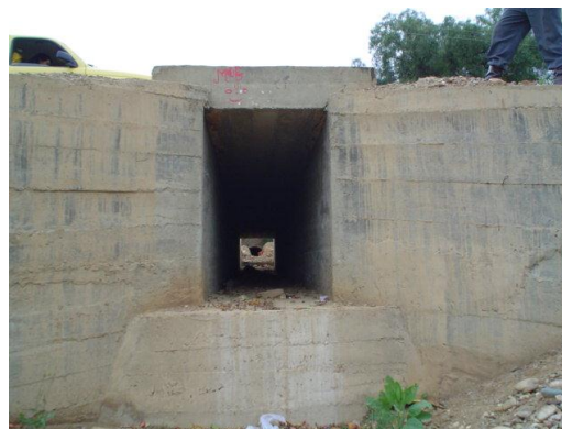
Salida de la alcantarilla
