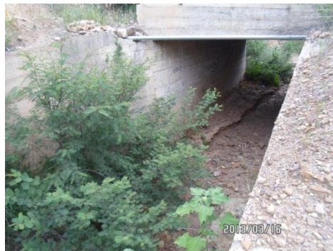
Salida de la alcantarilla
