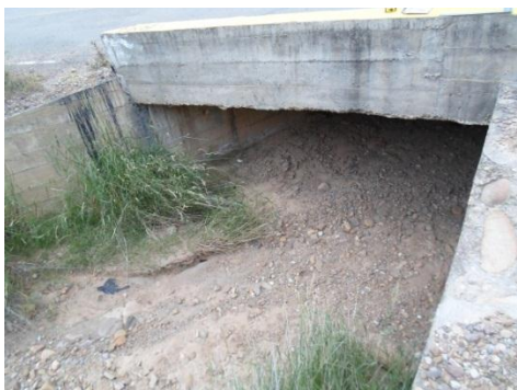
Entrada de la alcantarilla
