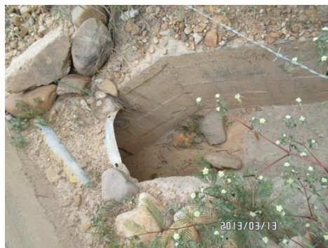
Salida de la alcantarilla
