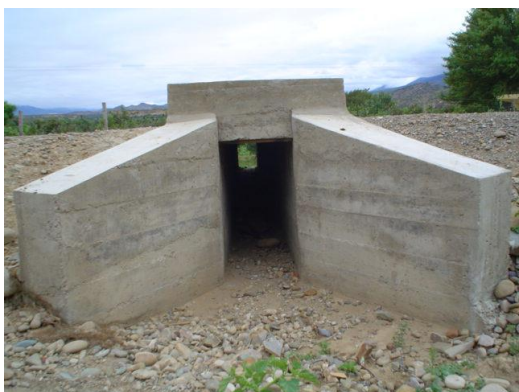
Entrada de la alcantarilla
