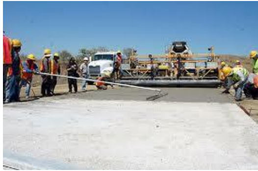
Figura 2.5.4. Acabado del Pavimento Rígido
