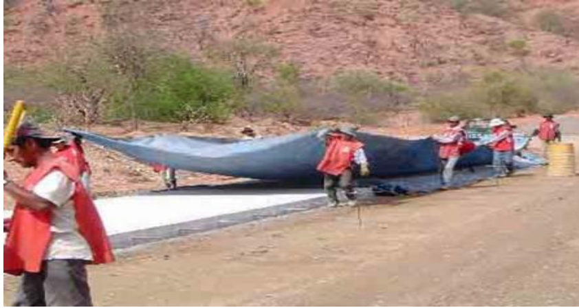
Figura 4.4.2 Protección del Pavimento en el proceso de Curado en Climas Fríos
