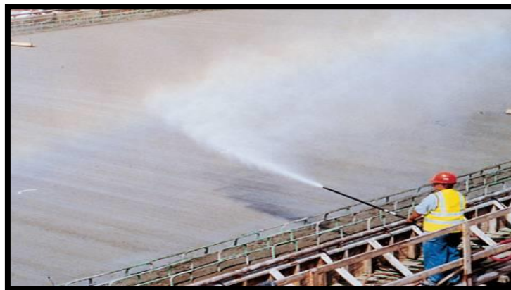
Figura 4.4.1 Técnica de Curado con Agua
