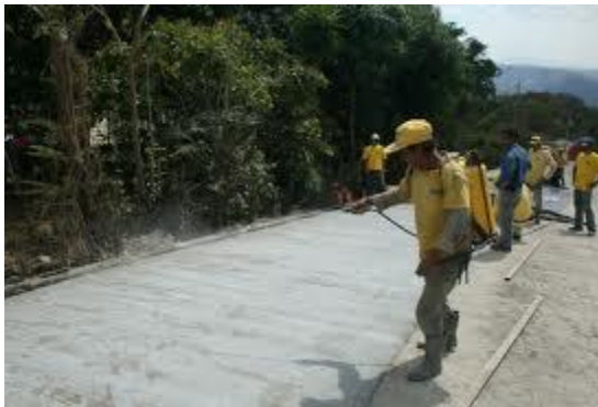
Figura 4.2.1. Curado Convencional
