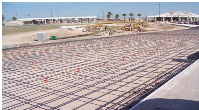
Figura 1.2.2. Pavimento rígido de concreto reforzado
