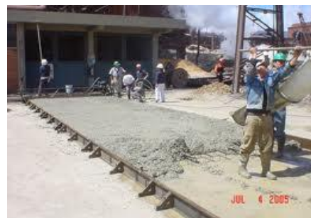
Fig. 2.5.3.1. Colocacion del Hormigon
