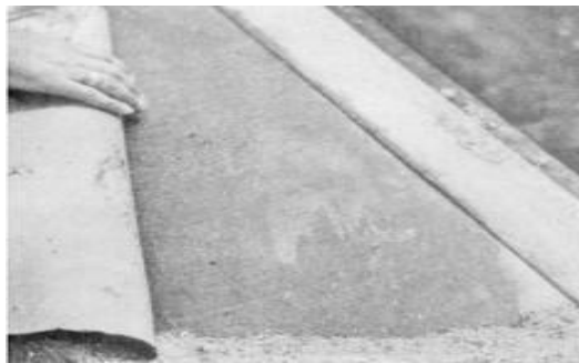
Figura 4.2.3.3. Curado con películas de plástico
