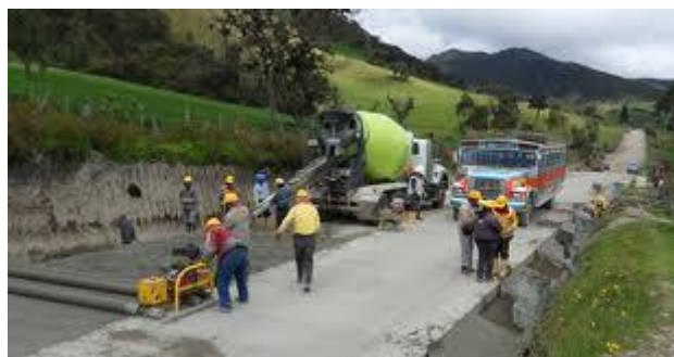
Figura 2.5.3. Transporte del Hormigón
