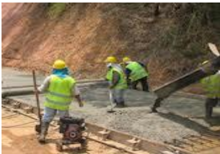
2.5.3.1. Colocacion del Hormigon
