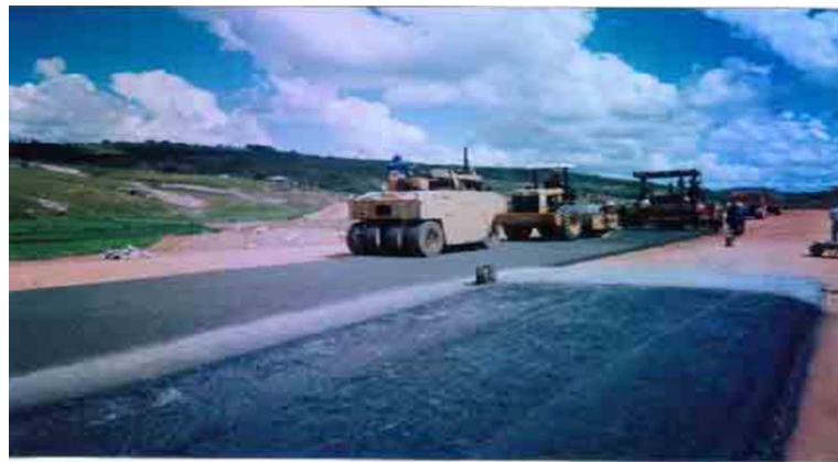
Figura 1.2.3. Pavimento rígido compactado con rodillo
