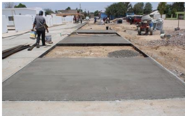
Figura 1.2.1. Pavimento rígido de concreto hidráulico
