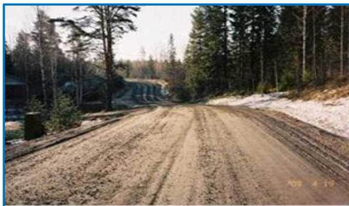
Figura N°10: Ahuellamiento
