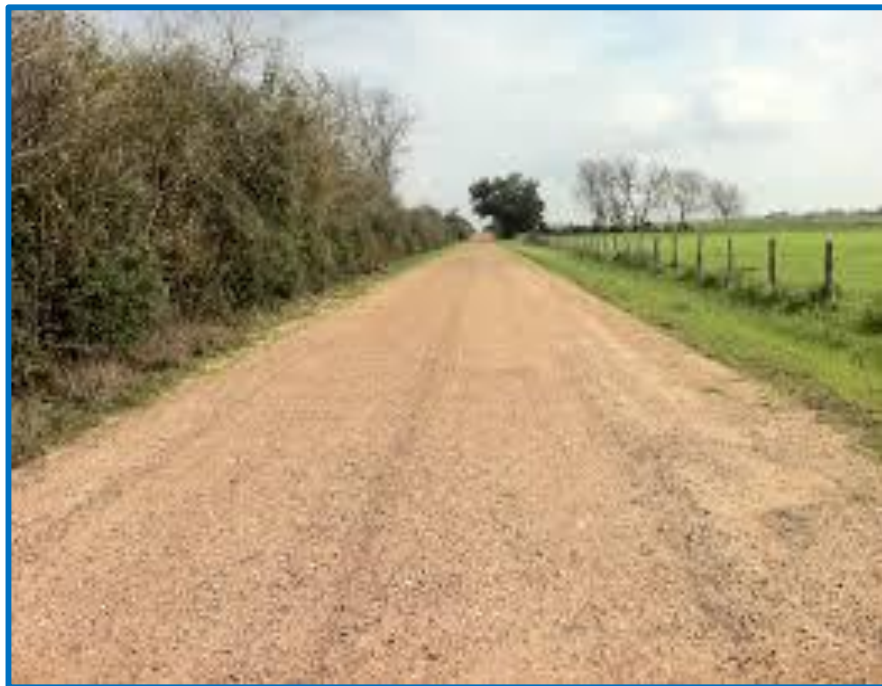
Figura N°2: Camino no asfaltado
