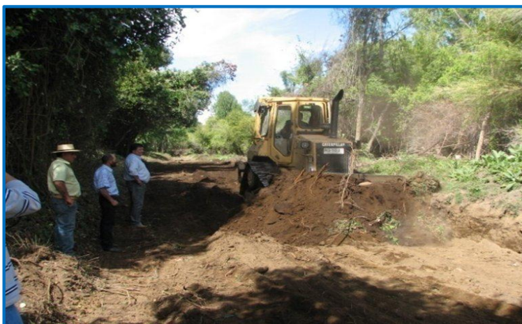
Figura N°20: Reparación de áreas inestables
