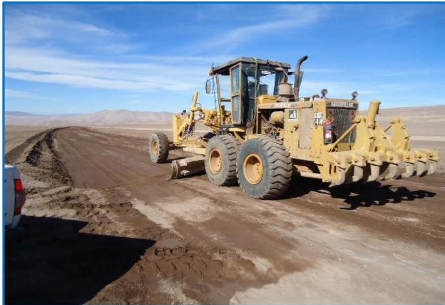
Figura N°17: Reperfilado
