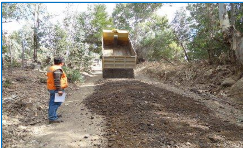
Figura N°22: Reparación de calzada con material integral
