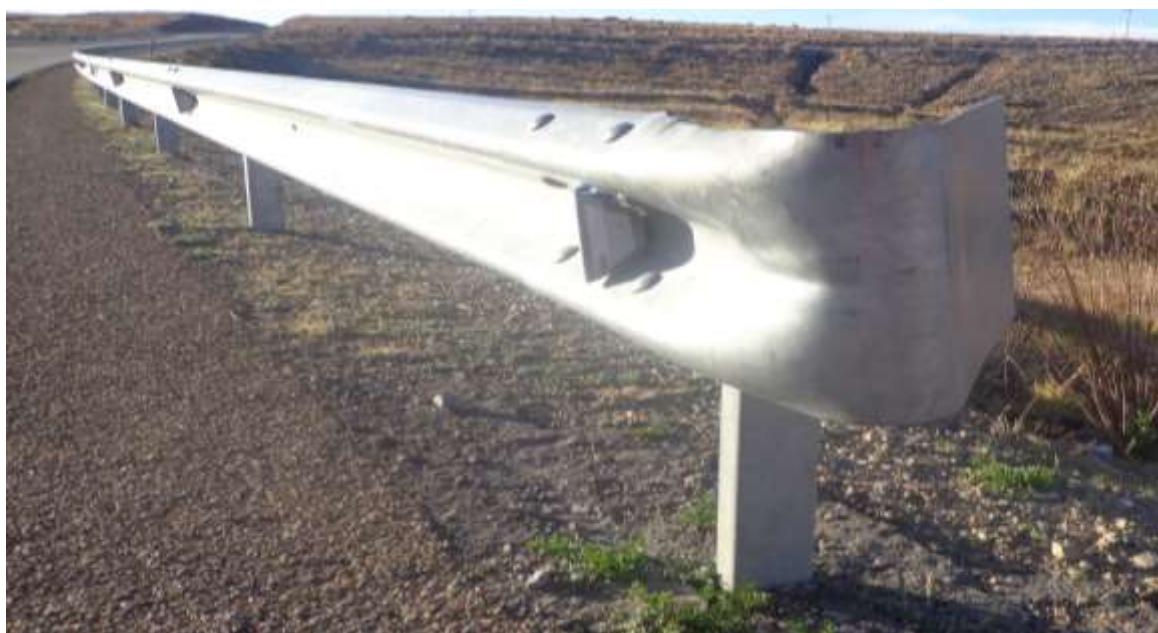
Figura Nro. 29 Barrera emplazada tramo de estudio
