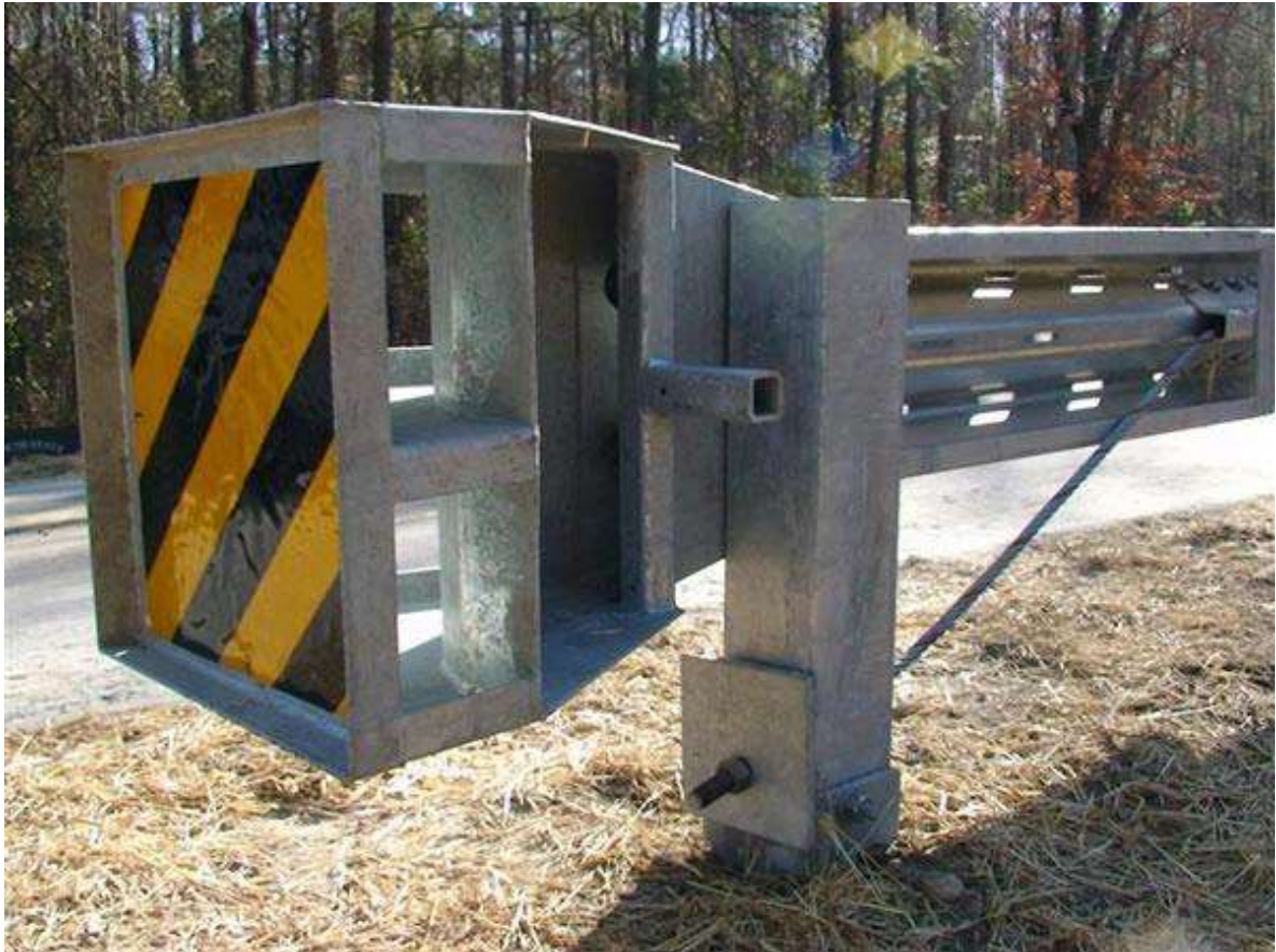
Figura Nro. 42 Terminal tipo A
