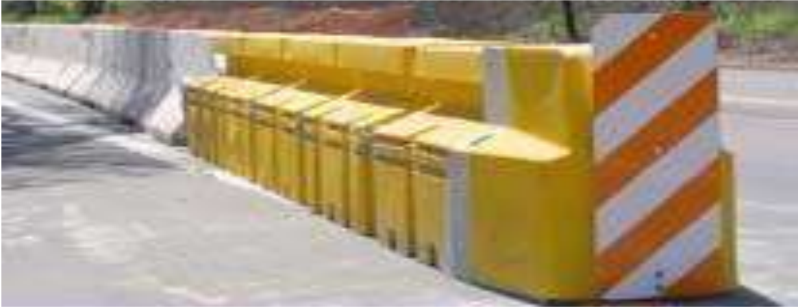
Figura Nro. 15 Amortiguador de impacto sistema ABSORB
