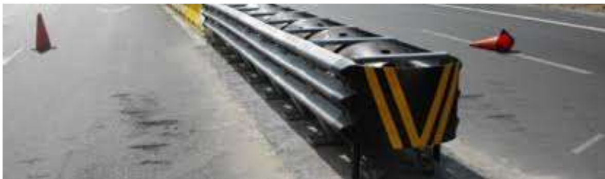
Figura Nro. 12 Atenuador de bajo mantenimiento (LMA)
