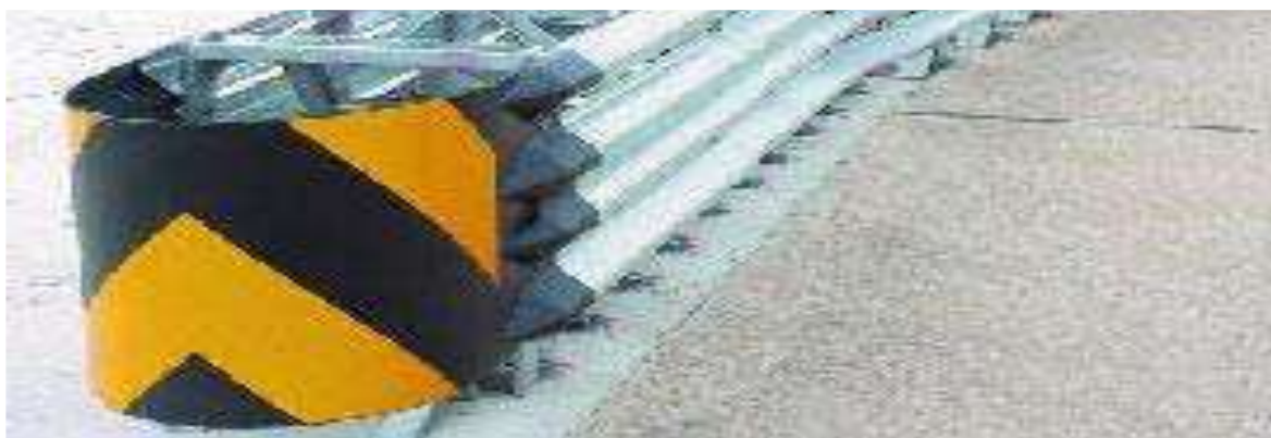
Figura Nro. 14 Amortiguador de impactos sistema TRACC
