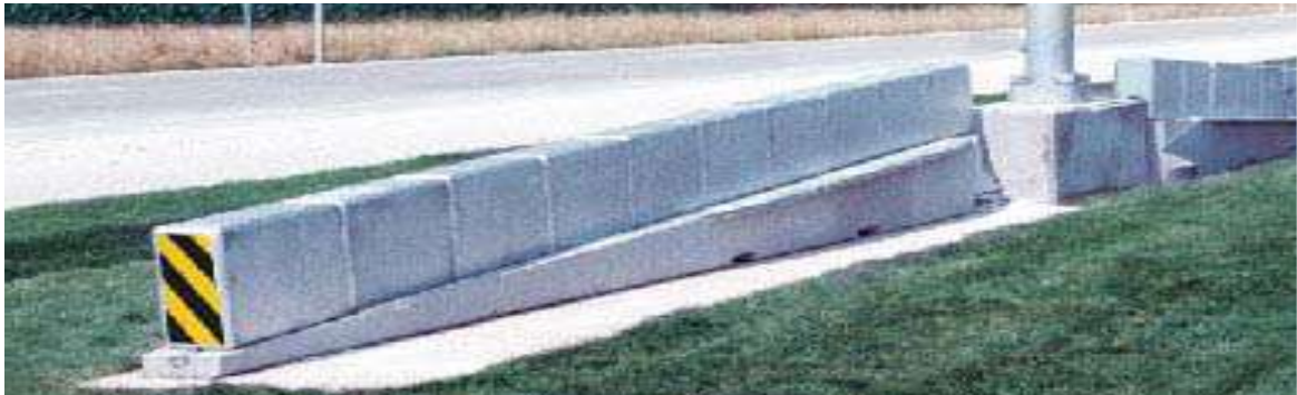
Figura Nro. 9 Terminal de extensión de impacto dinámico
