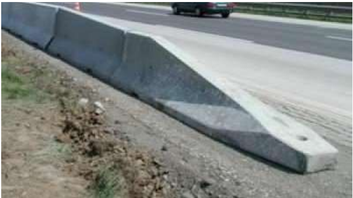
Figura Nro. 5 Terminales abatidos para barreras rígidas
