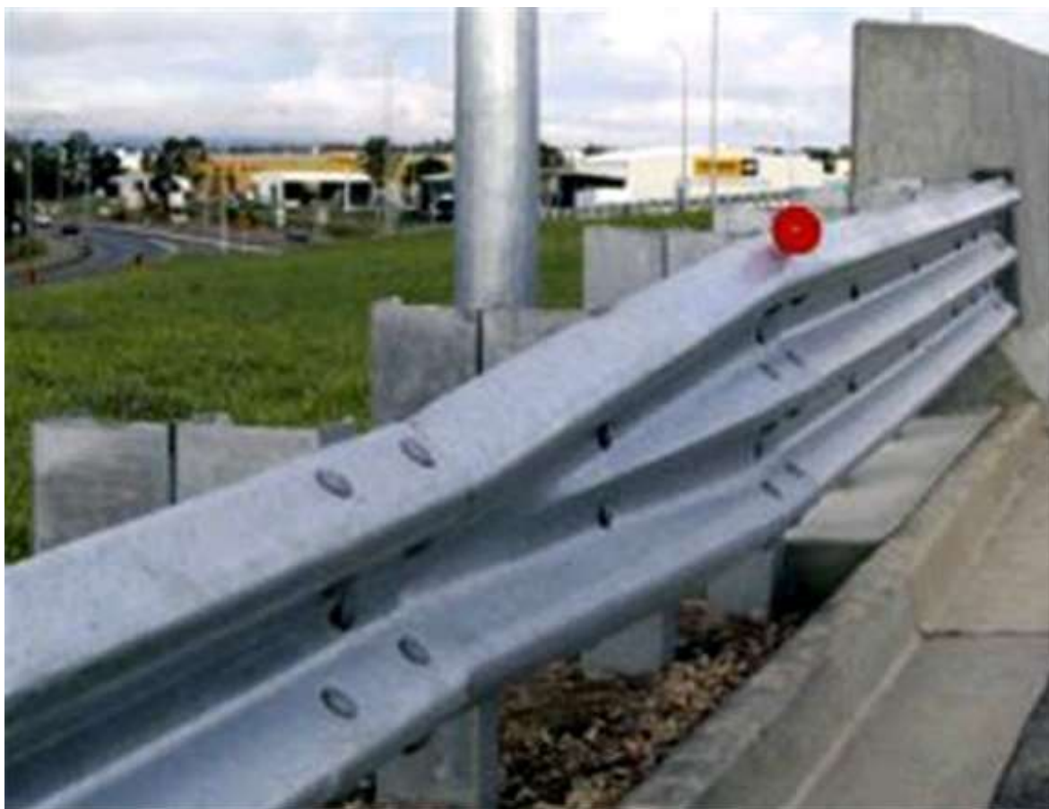
Figura Nro. 50 Transición de barrera W de 3 a 2 ondas
