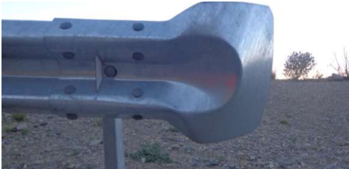
Figura Nro. 27 Terminal existente tipo aleta
