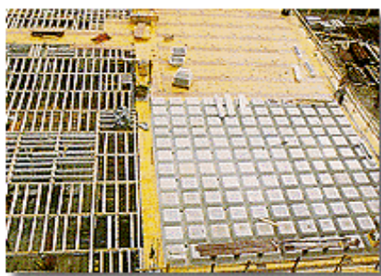
Figura 2.21: Vista del armado con mallas electro-soldadas
