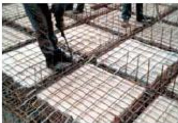
Figura 2.20: Vista detalle de armado y aligerante
