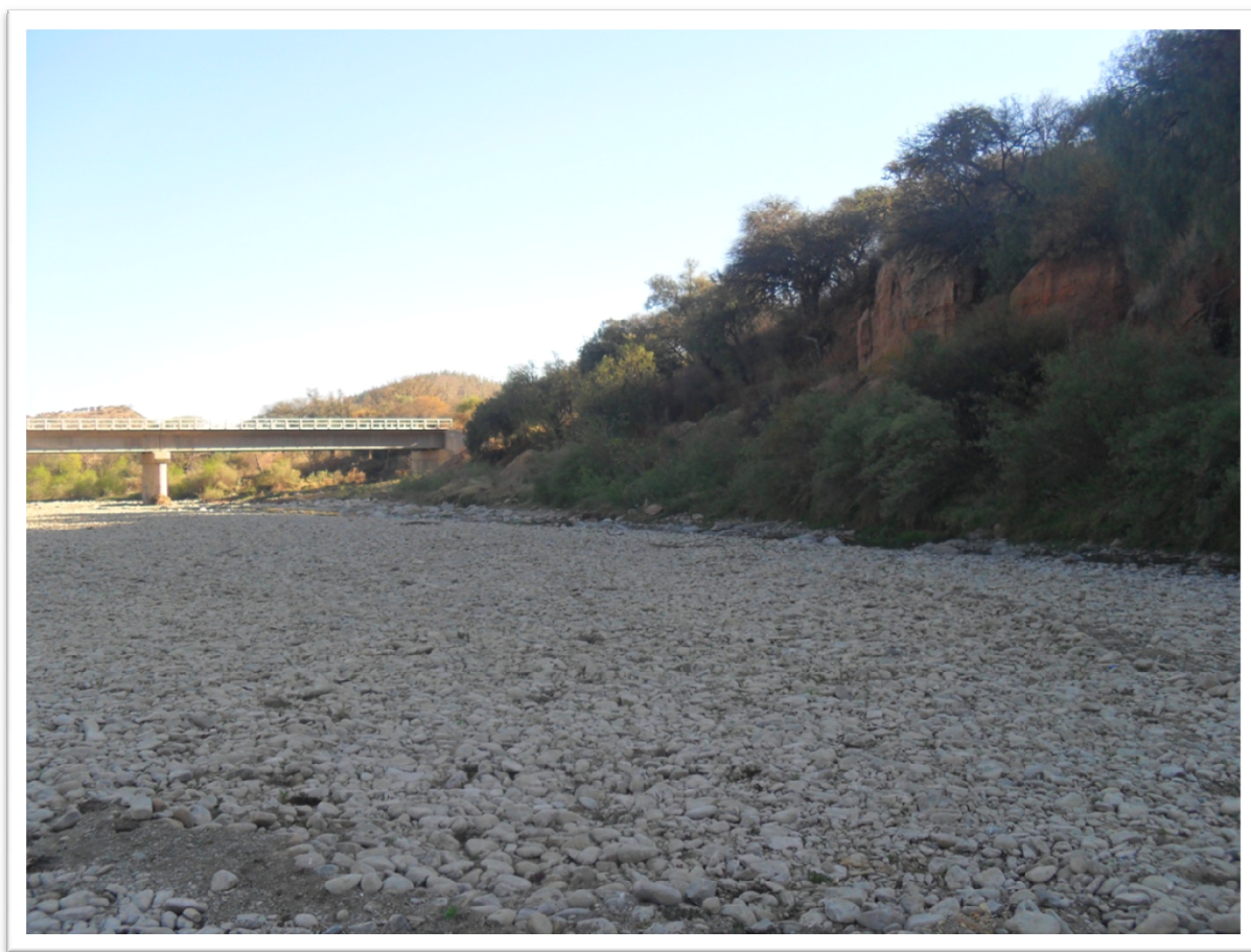
FOTOGRAFÍA 3.1.- Banda derecha del tramo en estudio aguas abajo de la sección de aforo.
