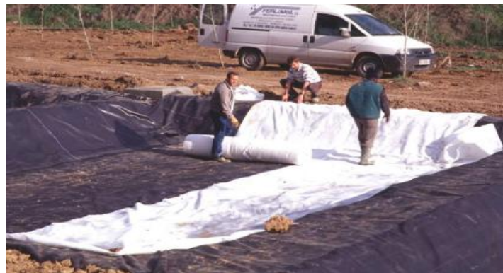
Fotografía 4.3 Impermeabilización de las celdas
