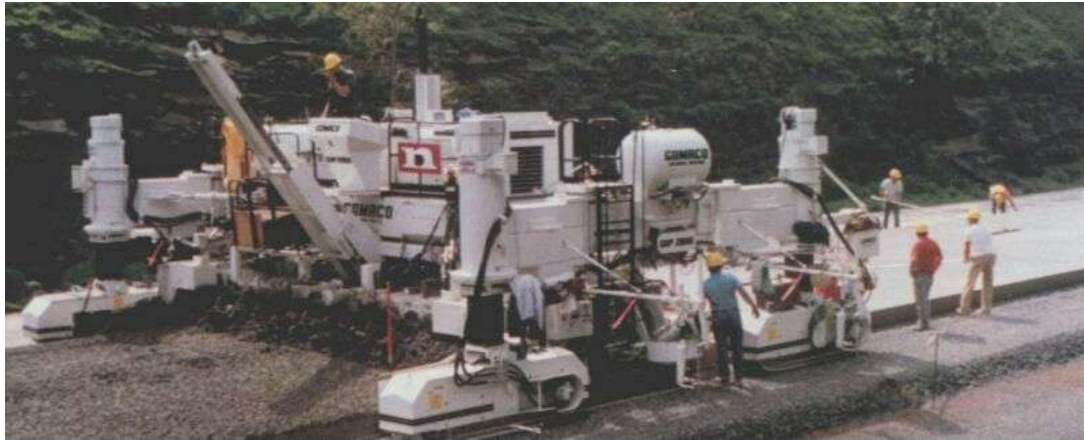
Figura 1.7. Conformación de la losa
