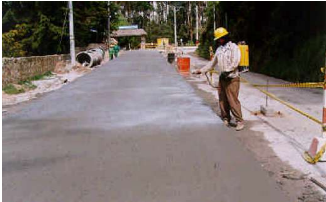
Figura 1.13. Curado de la Superficie del pavimento mediante riego
