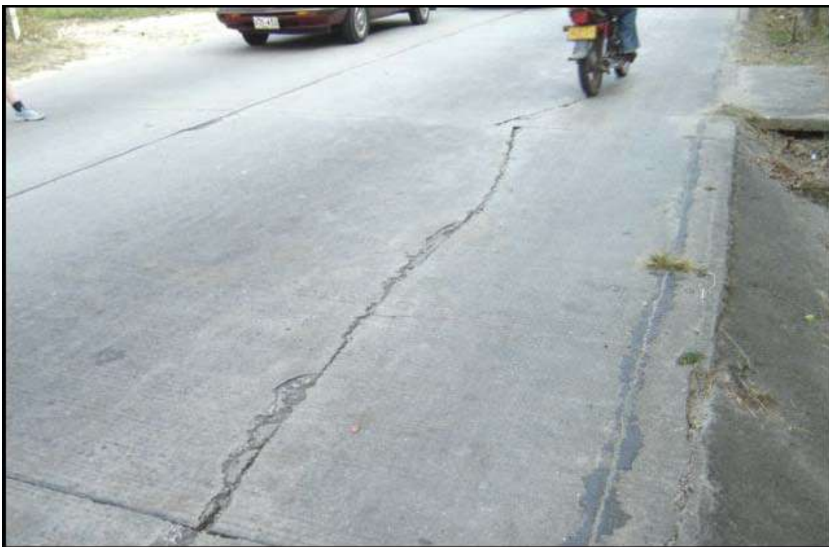
Figura 2.5 Grieta longitudinal
