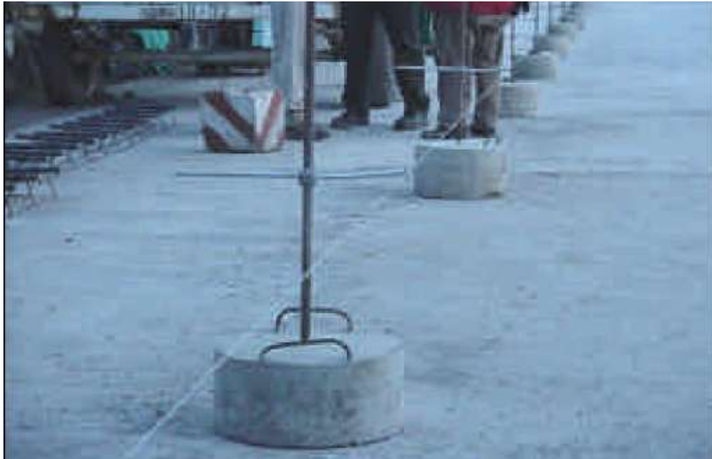
Figura 1.9. Control del hilo guía
