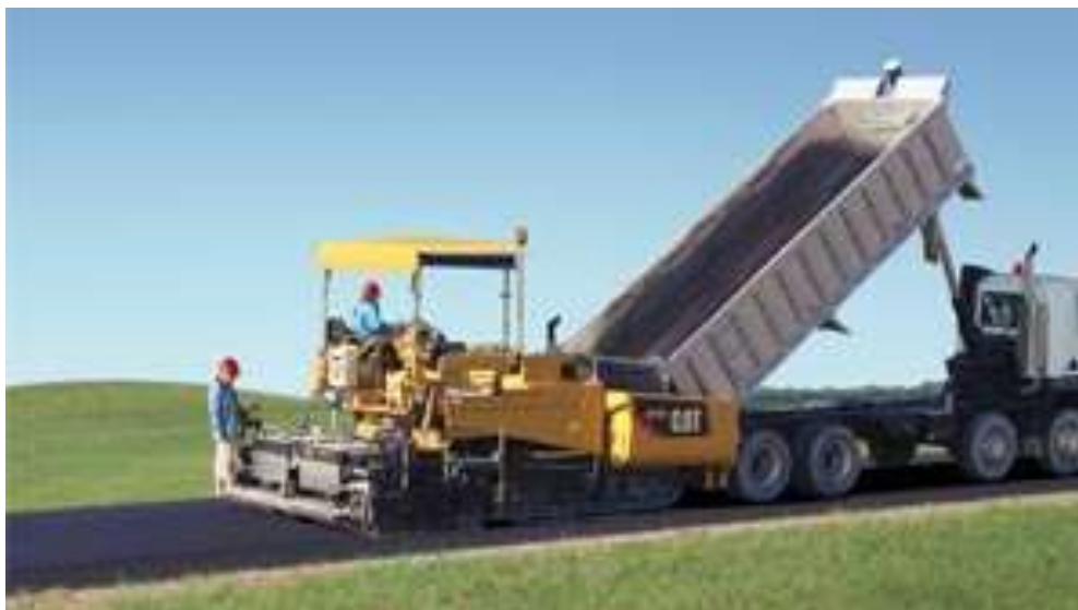
Figura 1.6. Descarga del camión a la extendidora.
