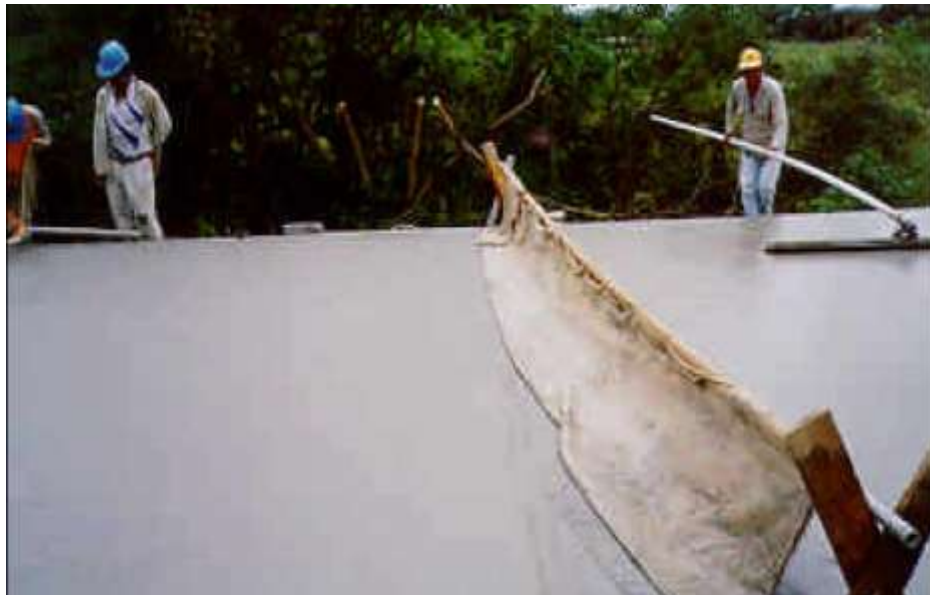
Figura 1.11. Microtextura
