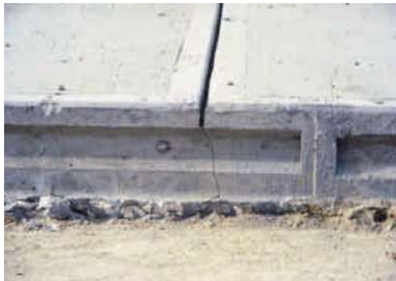
Figura 1.14. Junta en fresco
