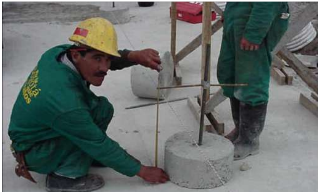
Figura 1.8. Colocación del hilo guía
