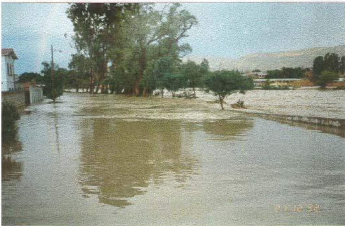
Figura 8.2. Inundación en la Avenida Los Membrillos
