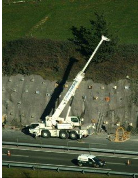
Fig. 2.19 Uso de anclajes con revestimiento de gunita.
