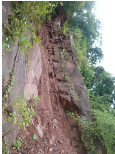
Fig. 4.13 Talud de estudio vista lateral.
