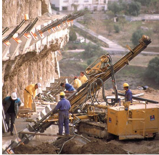
Fig. 3.36 Montaje de los anclajes de cables
