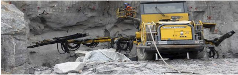
Fig. 3.39 Perforación y tesado de anclajes de cables en un talud.
