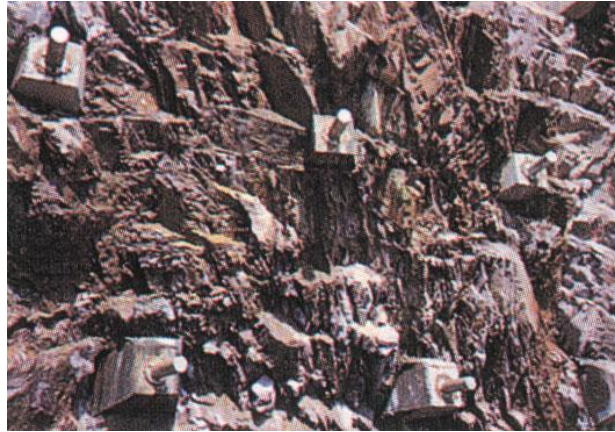
Fig. 3.14 Vista de cabezas de anclajes de cables.
