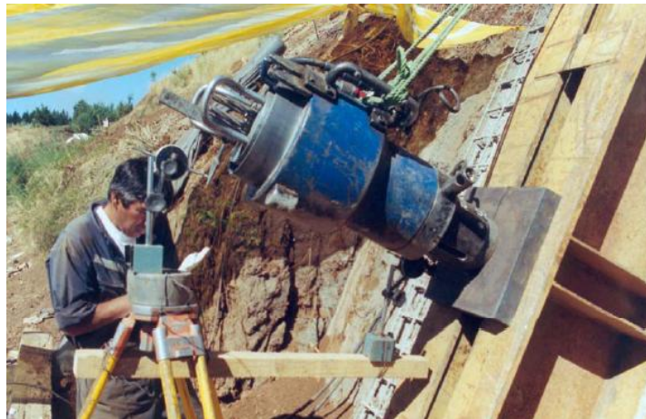
Fig. 3.37 Tesado de los anclajes con cables.
