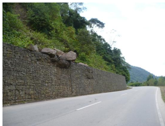
Fig. 4.8 Invasión de grandes masas rocosas hacia la calzada.
