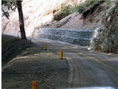
Fig. 2.14 Uso de Gaviones contra deslizamientos.
