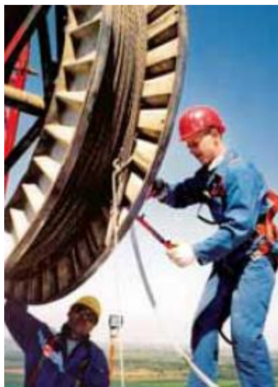
Fig. 3.35 Montaje de los cables en obra.
