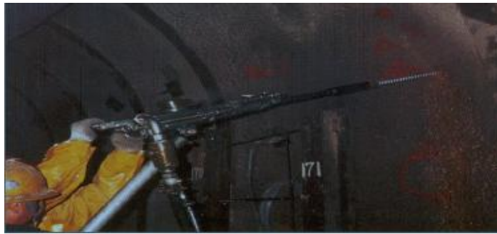
Fig. 3.41 Inyección de lechada de cemento al bulón
