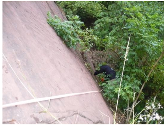
Fig. 4.16 Toma de datos geométricos del talud de estudio.
