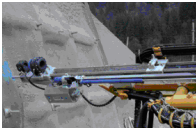
Fig. 3.38 Perforación y colocado de bulones
