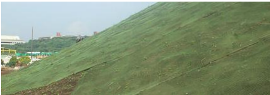
Fig. 2.15 Revegetalización del talud.
