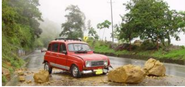
Fig. 2.17 Caído de roca en carreteras y caminos.
