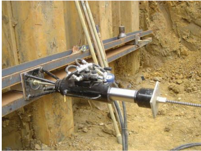
Fig. 3.40 Tesado de los bulones.
