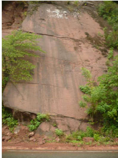
Fig. 4.12 Talud de estudio vista frontal.
