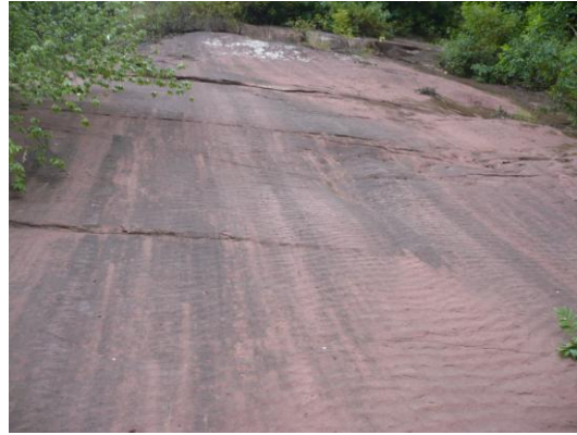
Fig. 4.14 Vista frontal inferior del talud de estudio.
