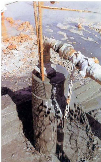
Fig. 3.12 Inyección de cemento en un anclaje de fundación.
