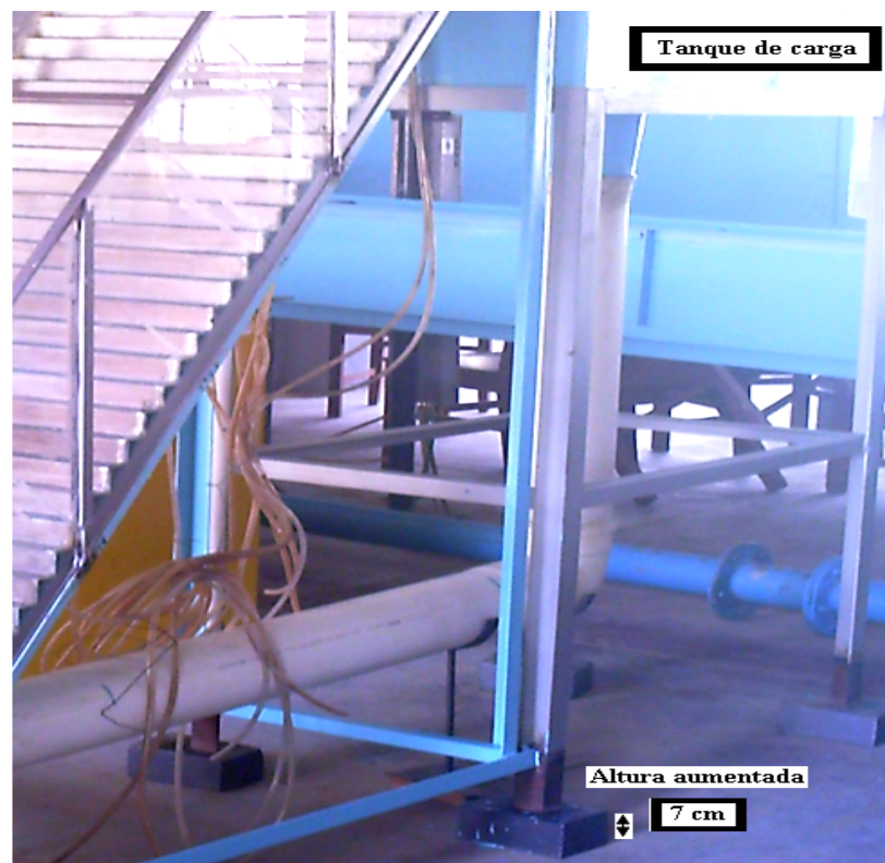
Foto 15: Soportes de madera aumentando 7 centímetros al tanque de carga instalado.
