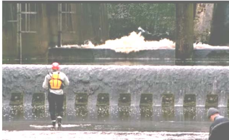
Foto 4: Estanque Amortiguador de la Presa de forcross situada en yorkshire (Reino Unido)
