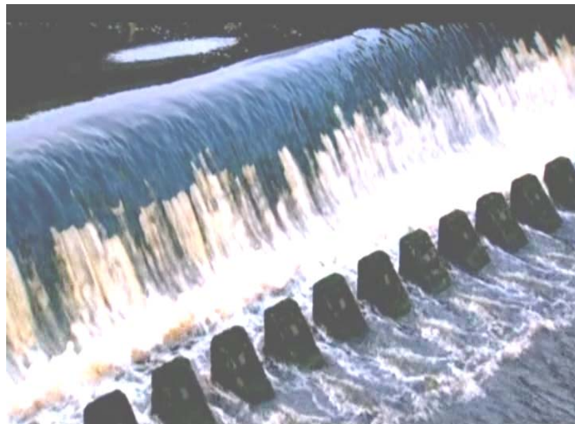
Foto 26: Dados amortiguadores en funcionamiento
