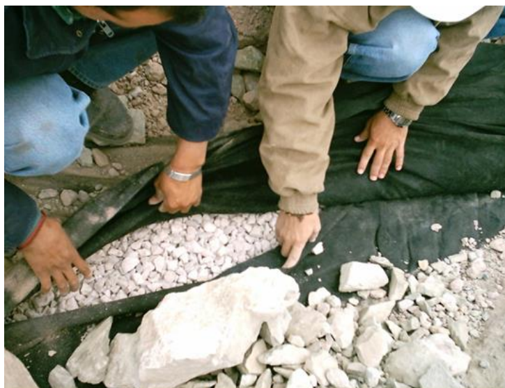
FIGURA 3. Detalle de drenes laterales
