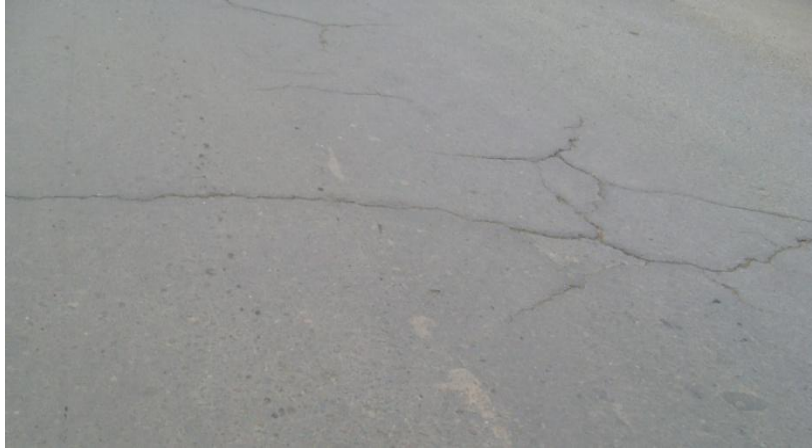
Figura 4.8. Grietas transversales
