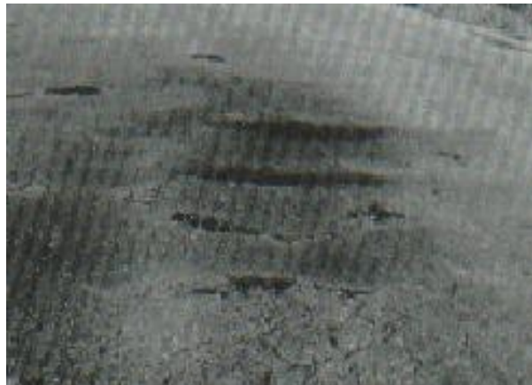
Figura 3.16 Deformación por Empuje
