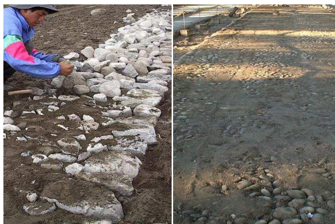
Figura 2.12 –Rellenado con material fino
