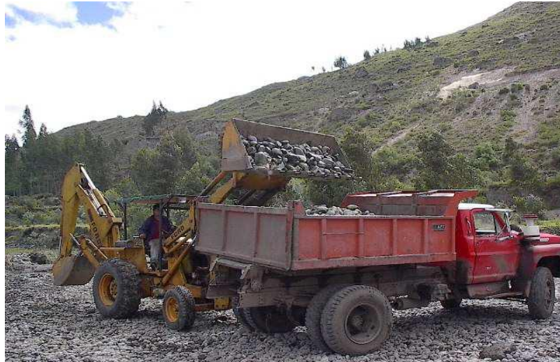
Figura 2.5. Carga de material a Volqueta
