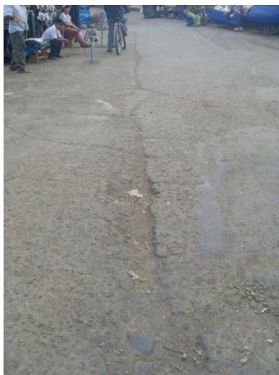
Figura 4.7. Grietas Longitudinales
