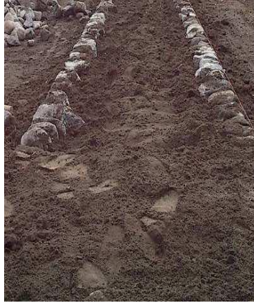
Figura 2.10 – Colocación de Maestras o Cordones maestros
