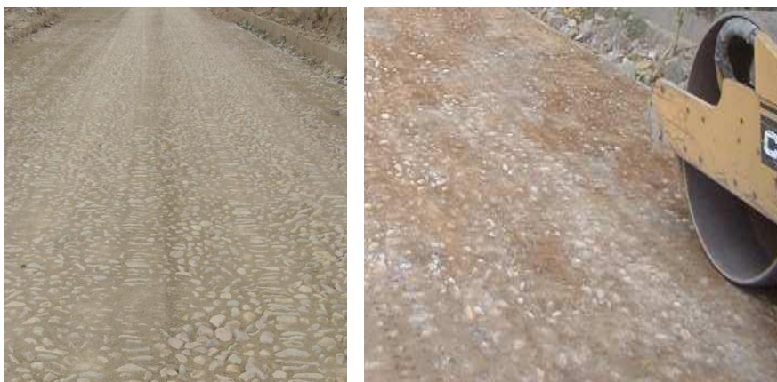
Figura 2.13 – Compactado del Emporado
