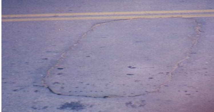
Figura 3.11 Bacheo y Zanjas reparadas
