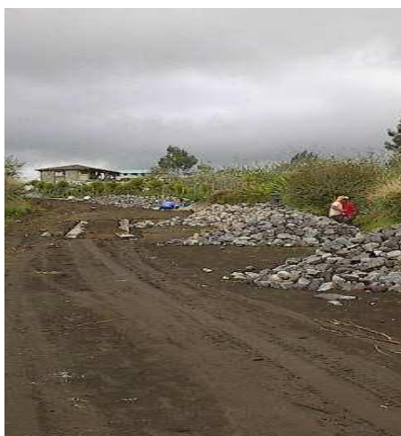
Figura 2.8 – Transporte y Acopio de Material en el Proyecto
