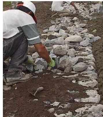
Figura 2.11 – Colocación e Hincado de Piedra en Empedrado
