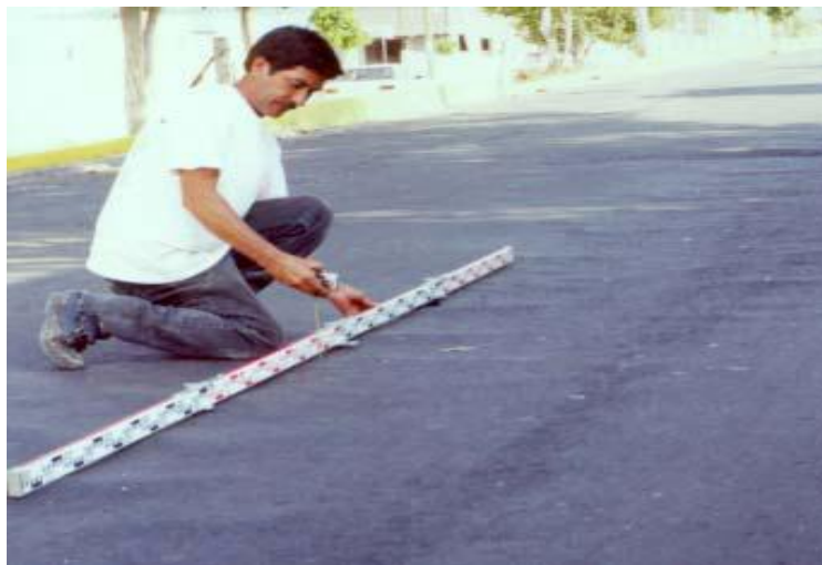
Figura 26 Aspecto superficial de ondulaciones en pavimentos flexibles
