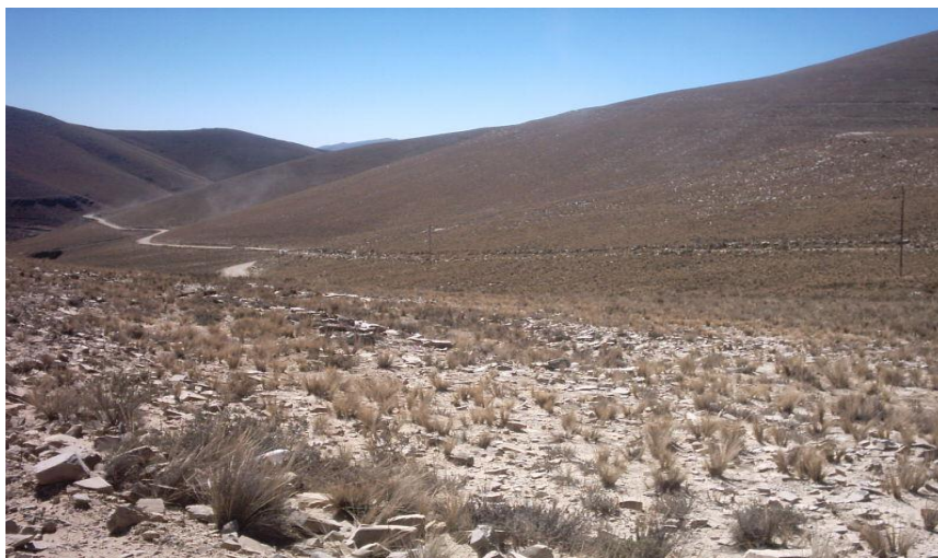
Figura 30 Se muestra parte de la carretera Iscayachi-Tojo-carretas
