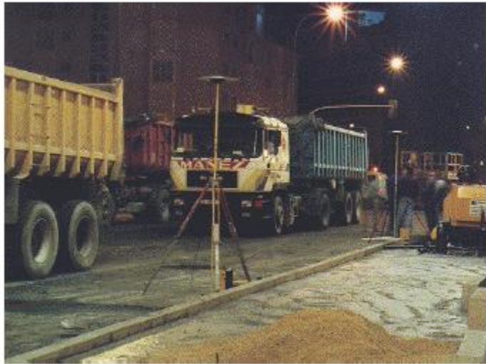
Fig. 4. Pruebas de carga y test con GPS del puente.
