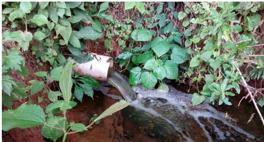
*Foto 2-21.* Descarga de la PTAR. Elaboración Propia
