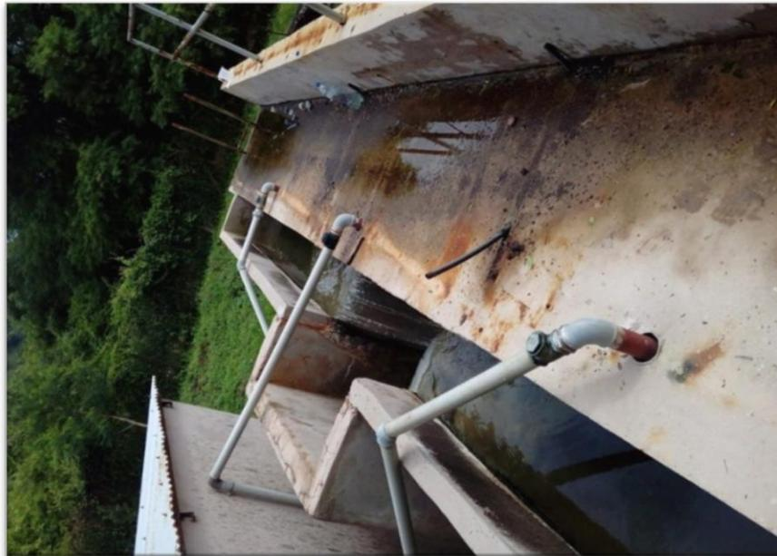
*Foto 2-10.* Tuberías para introducir aire al Tanque de Aireación. Elaboración Propia
