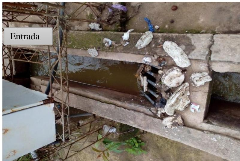
**Foto 2-19.** Canal de entrada de Aguas Residuales a la PTAR. Elaboración Propia
