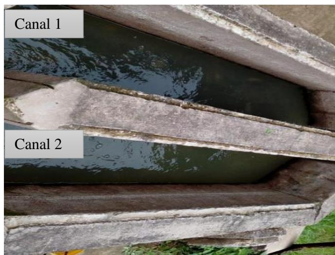
**Foto 2-20.** Canales paralelos (desarenador). Elaboración Propia
