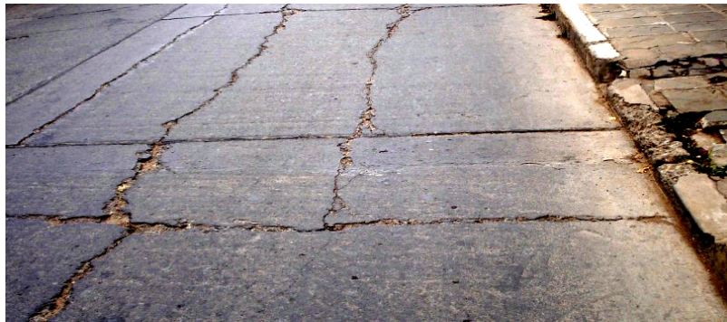
Figura 2.11 AGRIETAMIENTO TRANSVERSAL
