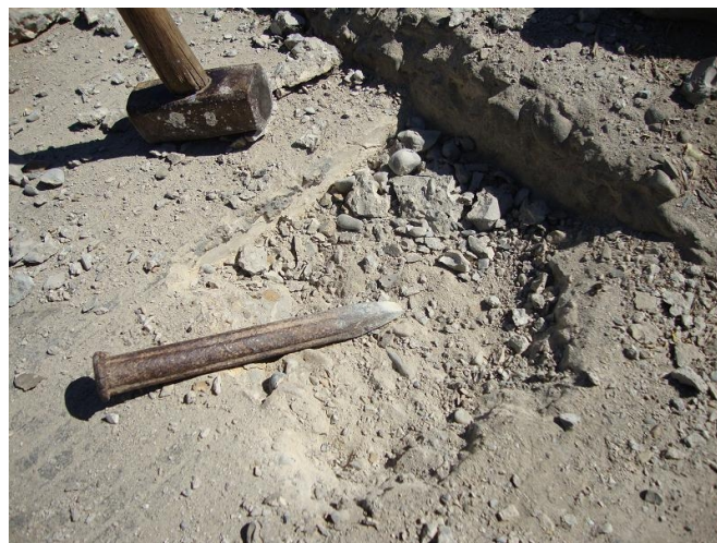
Figura 4.5 (Comienzo de fresado de la losa)
