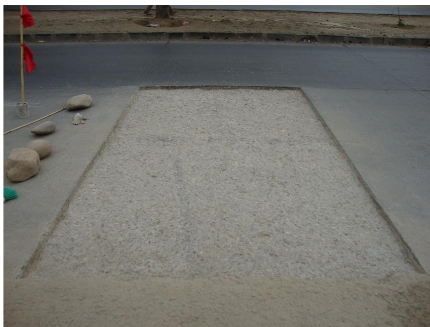
Figura 4.8 (Área de trabajo Fresada con un profundidad de 5 centímetros)
