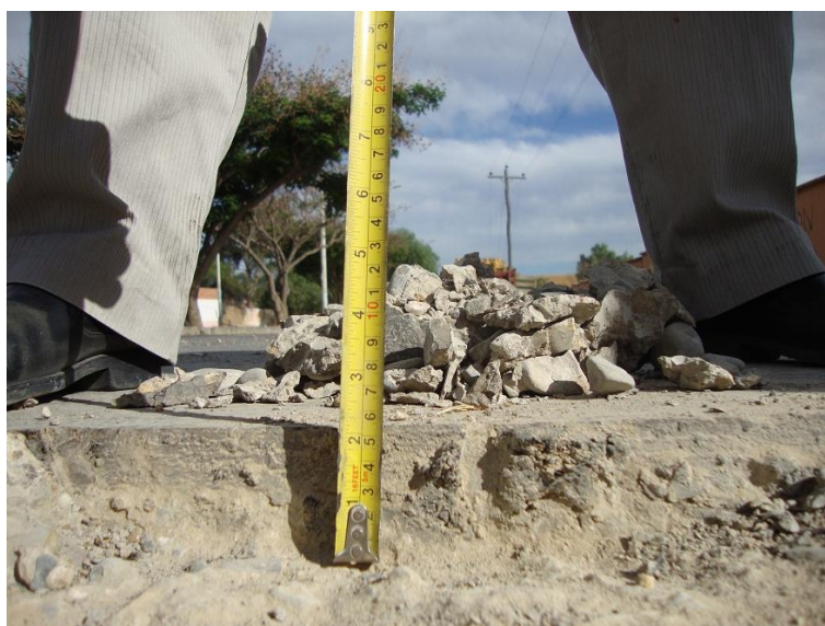
Figura 4.7 (Control de altura en la pared posterior de la losa)
