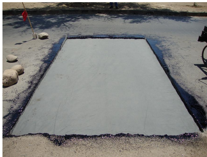
Figura 4.26 (Colocado final del geotextil)
