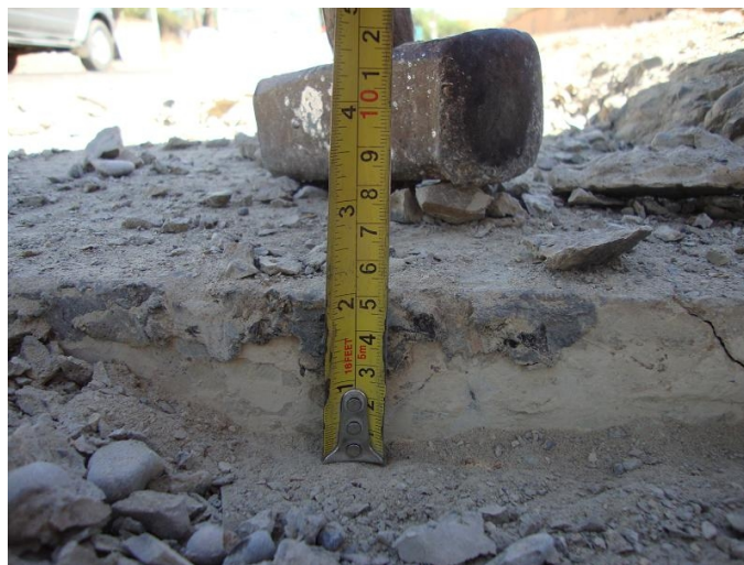
Figura 4.6 (Control de altura en la pared anterior a la losa)
