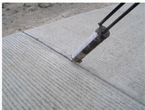
Figura 2.15 Colocación del sello en una junta transversal.
