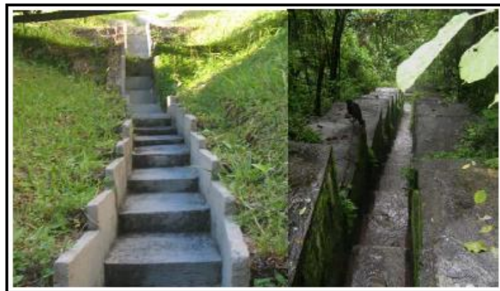
Fotografía N° 12 Rápidas escalonas de Concreto
