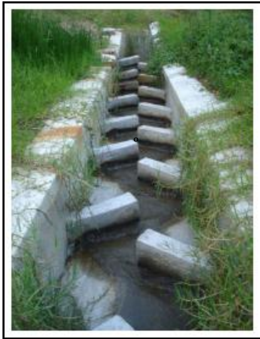
Fotografía N° 13 Canal de Pantallas Deflectoras (CPD)
