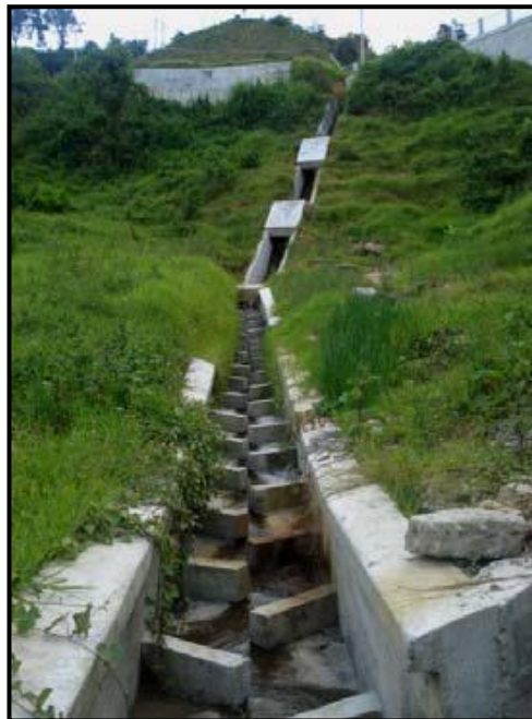
Fotografía N° 15 Combinación de un CRTC y CPD
