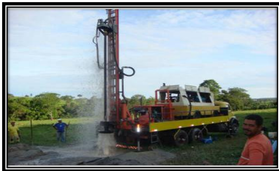
Figura 4.11: Maquinaria de perforación de pozos de agua
