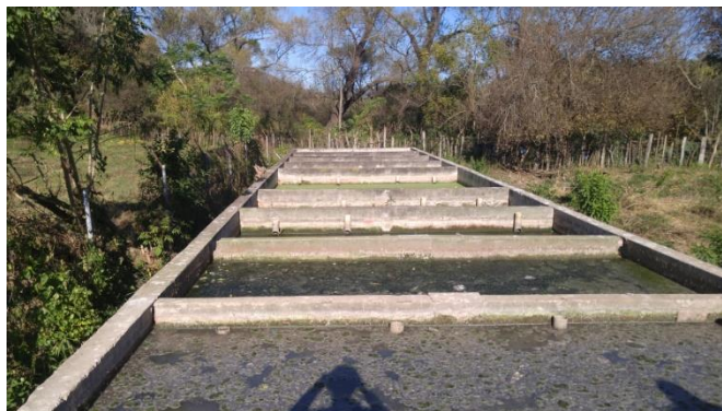
FIGURA 37. Fotografía de la PTAR de la ciudad de Entre Ríos.
