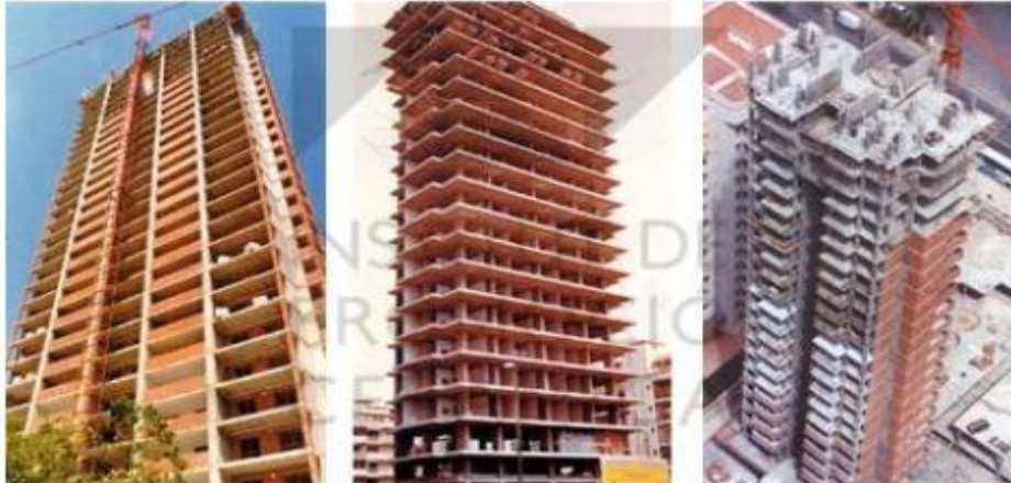
Edificios de altura resueltos con forjados reticulares y pantallas verticales (para absorber los empujes horizontales).
