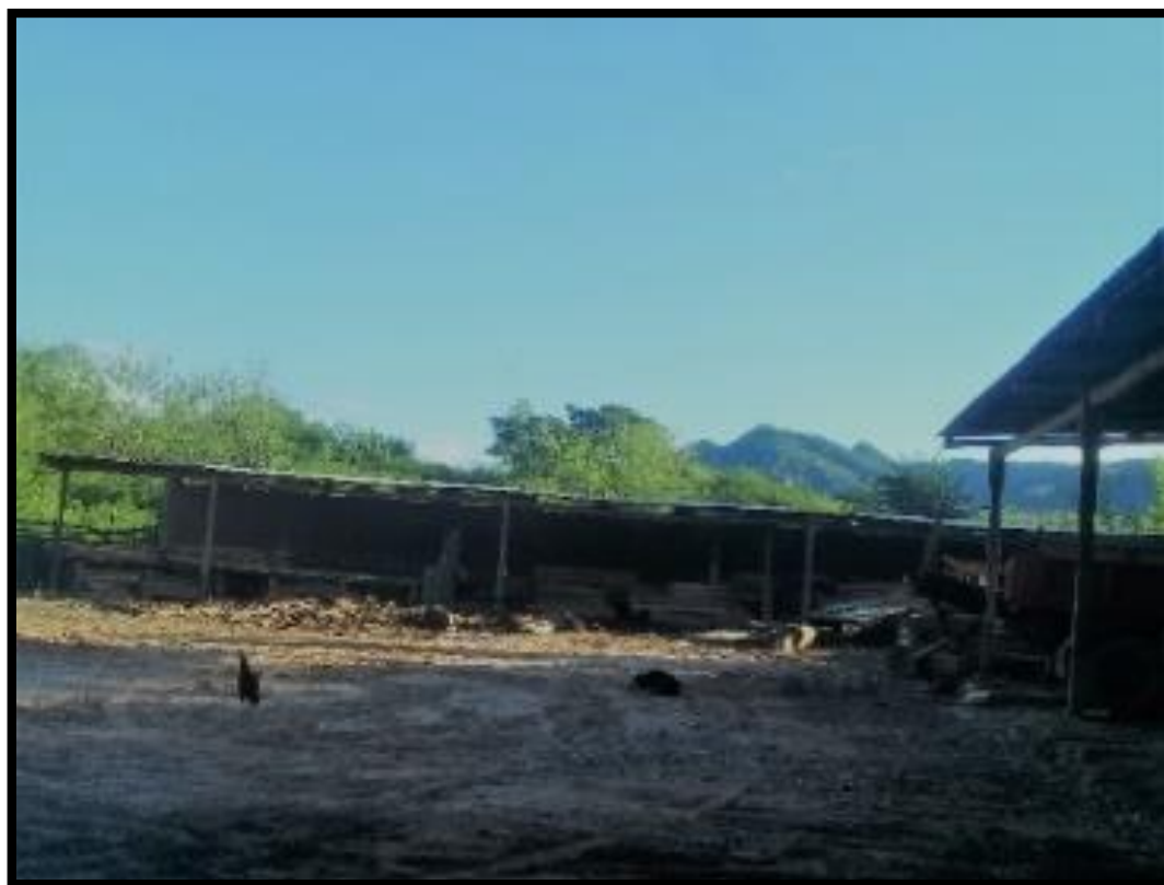
FOTO N° 1 Cerramiento perimetral del Aserradero San José
