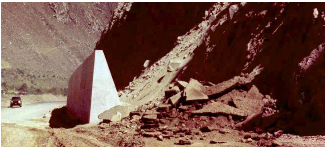
Fotografía 3G Muro de Contención de Hormigón Simple o sin Refuerzo
