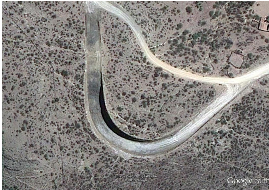
Fotografía 5C Talud 3 progresiva 26+080 (en una curva)
