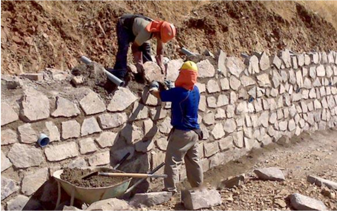
Fotografía 3H Construcción de un Muro de Hormigón Ciclópeo
