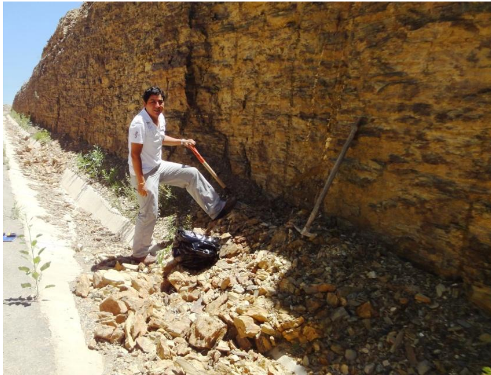
Fotografía 5F Cargado del material.
