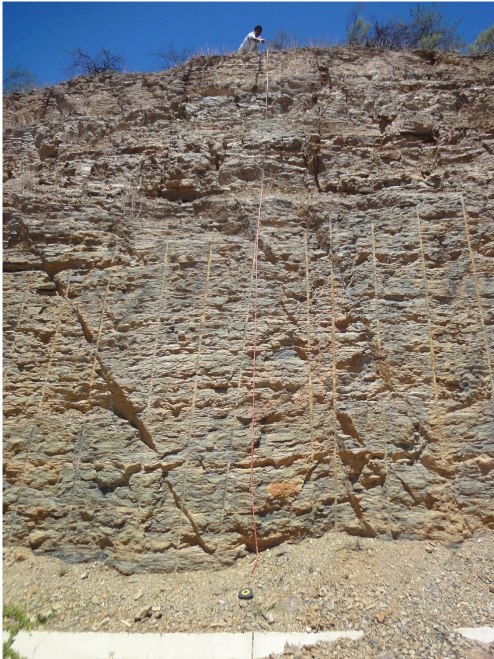
Fotografía 5E Medición de la altura del talud
