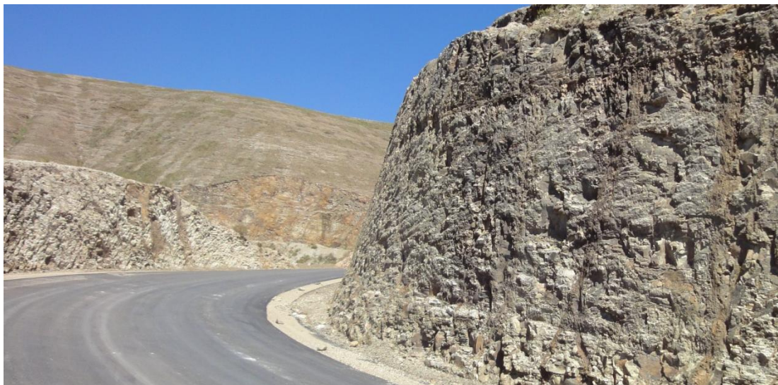
Fotografía 2B Talud Artificial
