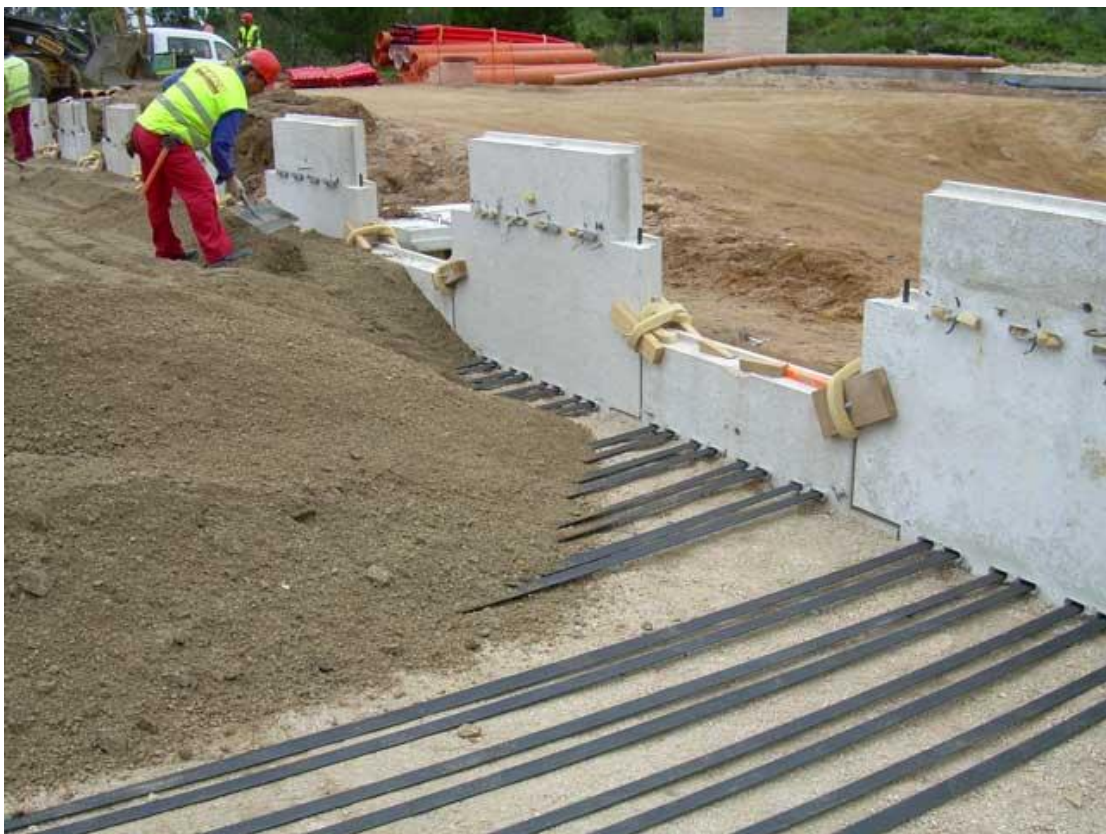
Fotografía 3M Detalle de las cintas Metálicas
