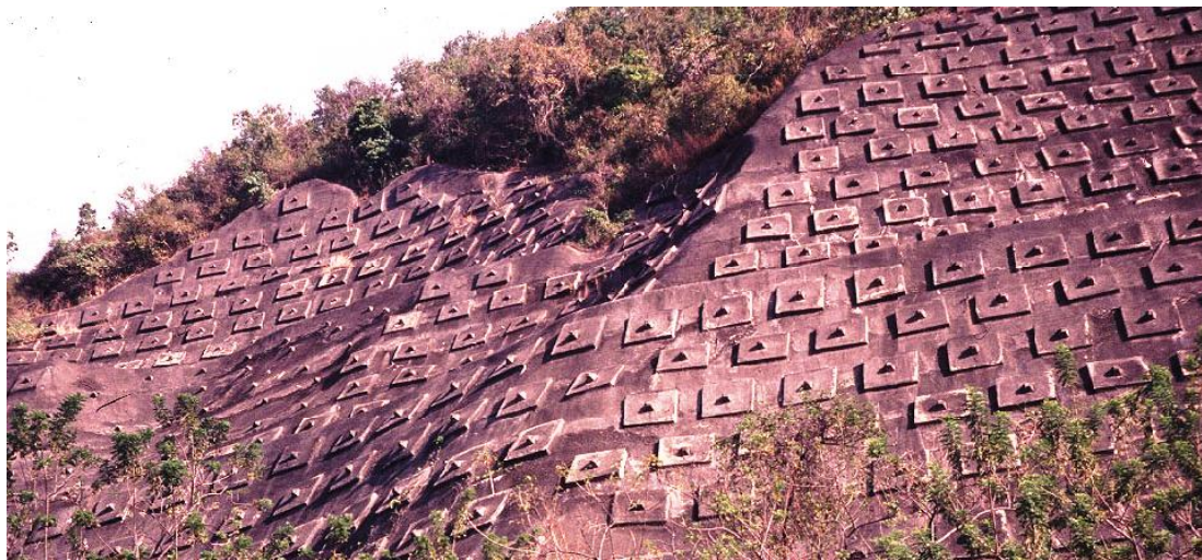
Fotografía 3S Muro Anclado
