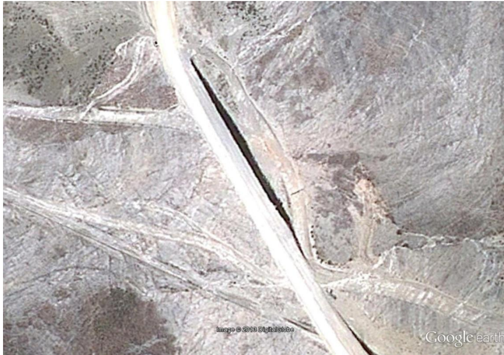
Fotografía 5A Talud 1 progresiva 6+620
