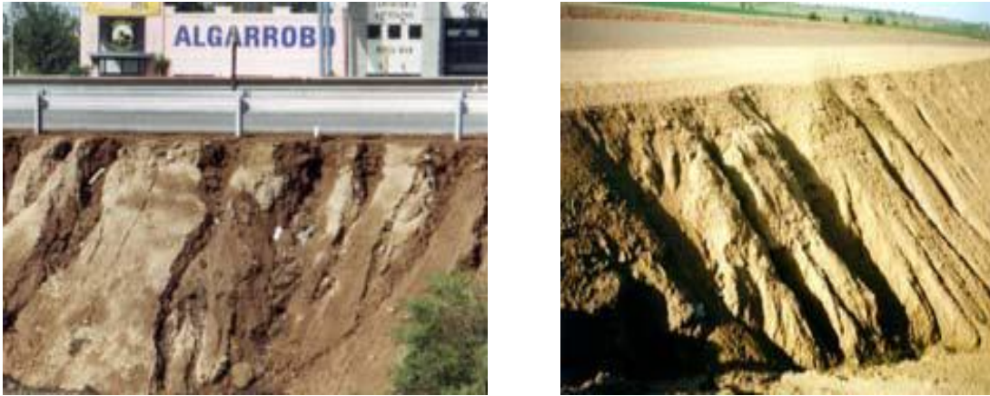
Fotografía 2C Taludes de Excavación
