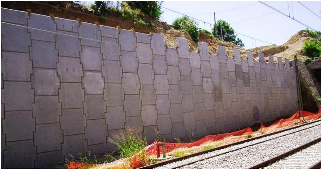
Fotografía 3L Construcción de Muro con Cintas Metálicas
