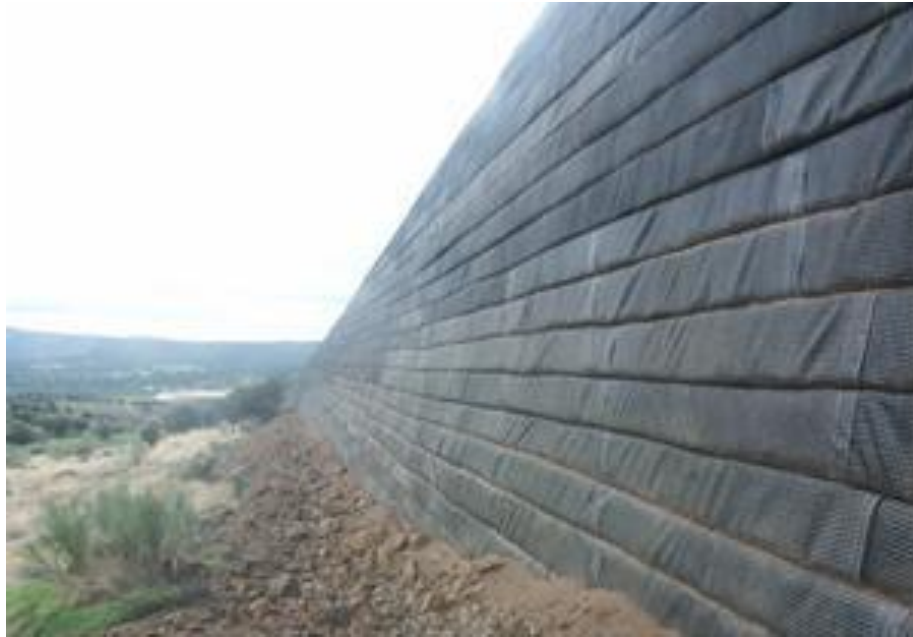
Fotografía 3N Muro con Refuerzo de Geotextil
