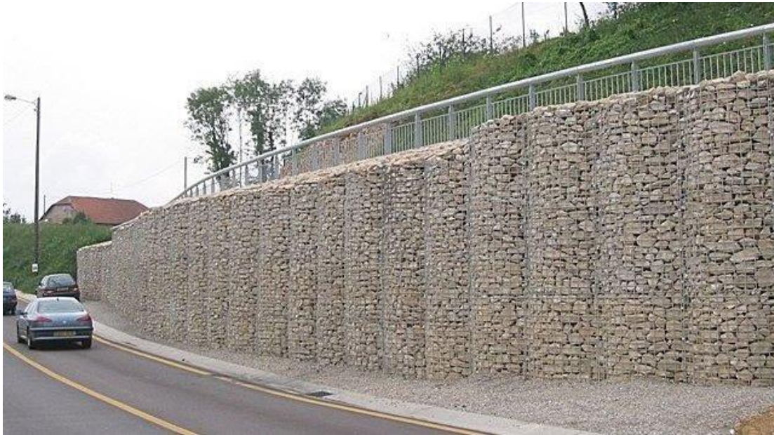
Fotografía 3I Muro de Gaviones
