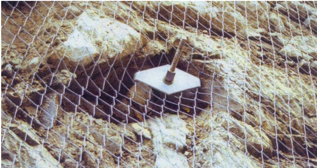
Fotografía 3R Perno Anclado con Malla Dinámica
