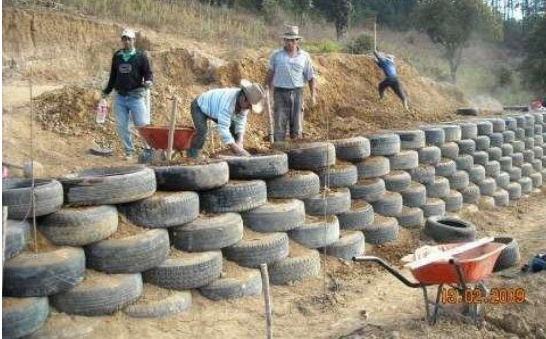
Fotografía 3K Construcción Muro Masivo Neusol
