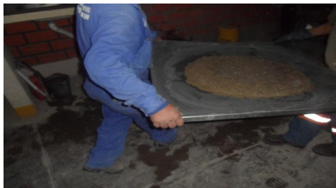
Foto 1 Segregación del hormigón
