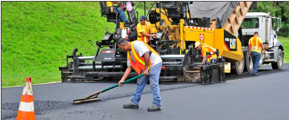
Figura 1: Mezcla asfáltica puesta en obra
