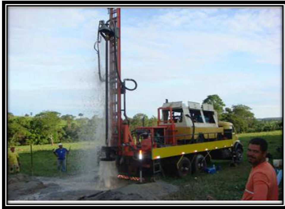
Figura 4.10: Maquinaria de perforación de pozos de agua
