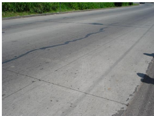
Figura 2.8 Fisura longitudinal
