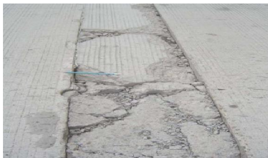
Figura 2.24 Parchados y reparaciones de servicios públicos
