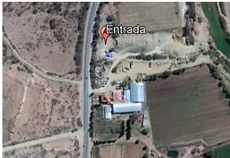
Imagen 3.1. Ubicación de la planta de asfaltos y trituradora de agregados de la alcaldía
