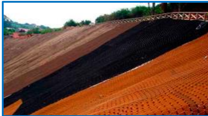
Figura N°5: Talud de una carretera
