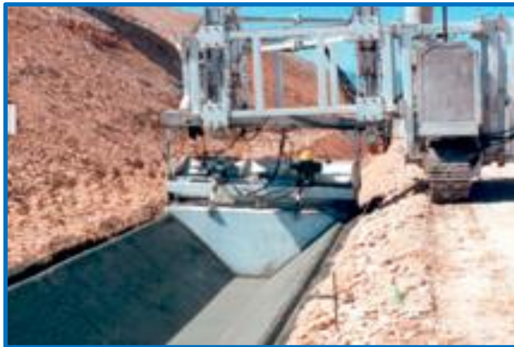
Figura N°4: Cuneta de una carretera
