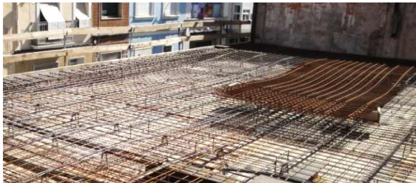
Figura 4. 8 Armadura pasiva superior
