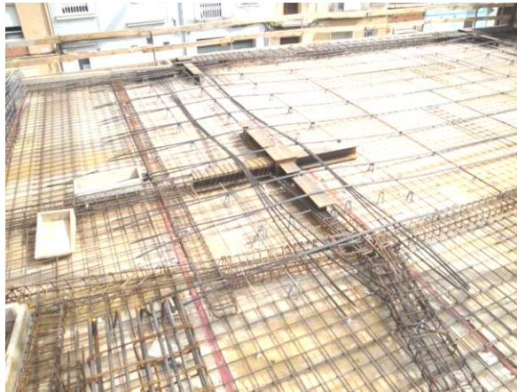
Figura 4. 4 Armadura inferior pasiva y armadura activa
