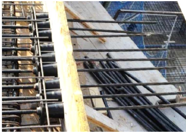
Figura 4. 6 Zona de anclajes activos
