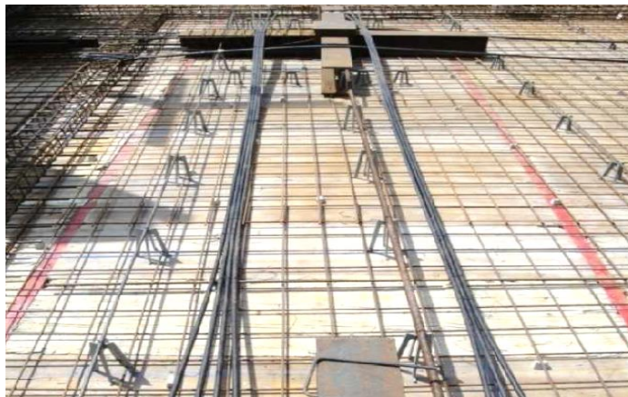
Figura 4. 7 Colocado de silletas
