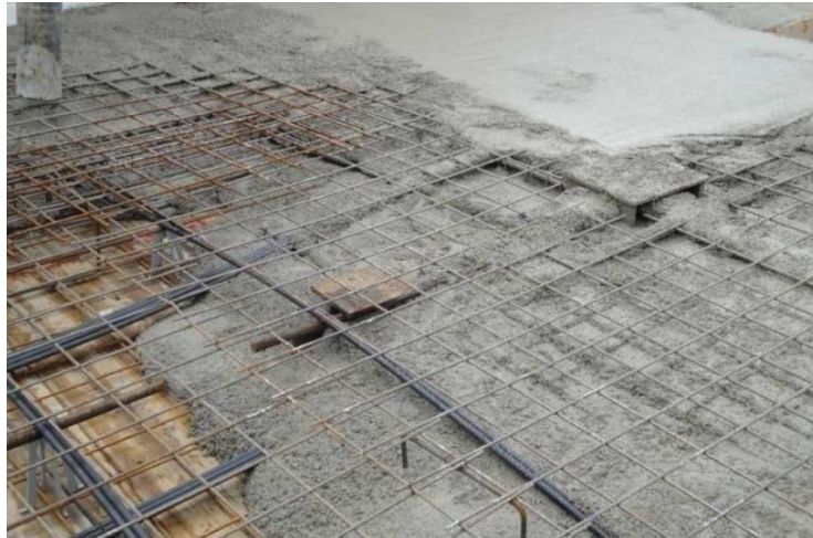
Figura 4. 9 Vertido del hormigón y vibrado
