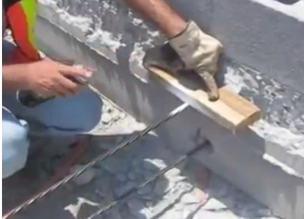
Figura 4. 11 Marcación para verificación de alargamiento
