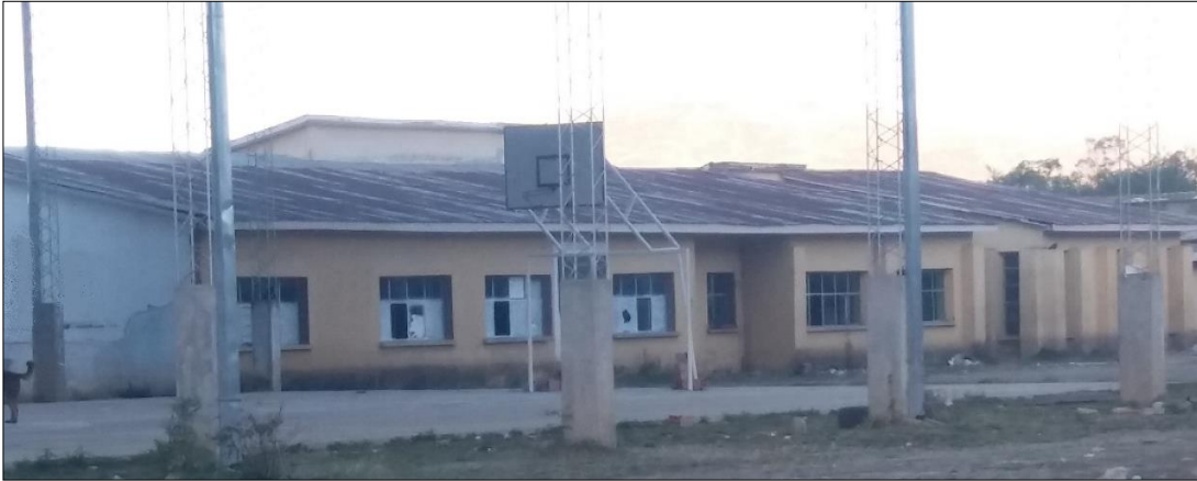
Fig. 1.1. Infraestructura actual del establecimiento educativo.
