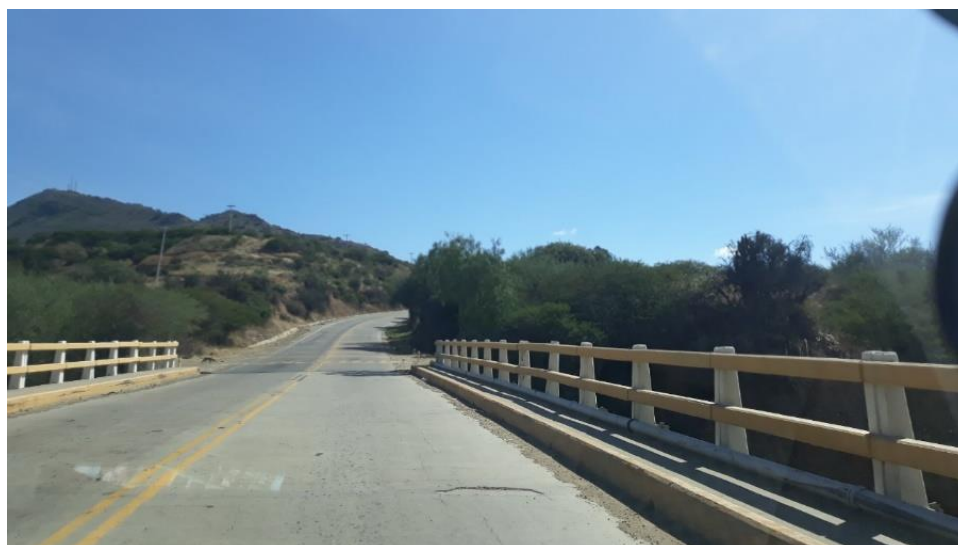
Figura 68. Puente de Santa Ana
