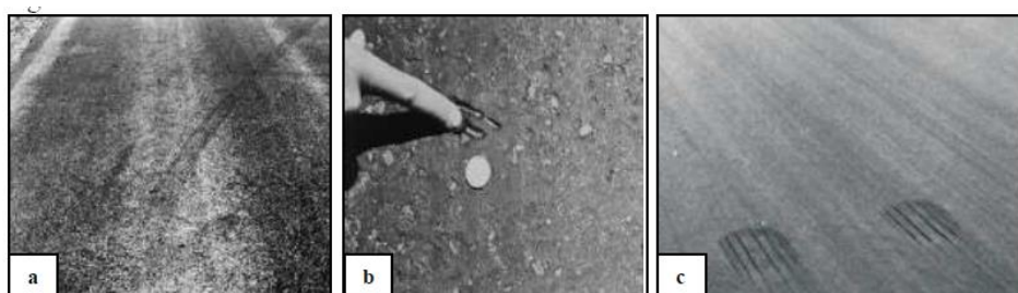
Figura 23. Exudación de nivel de severidad bajo (a), medio (b) y alto (c).
