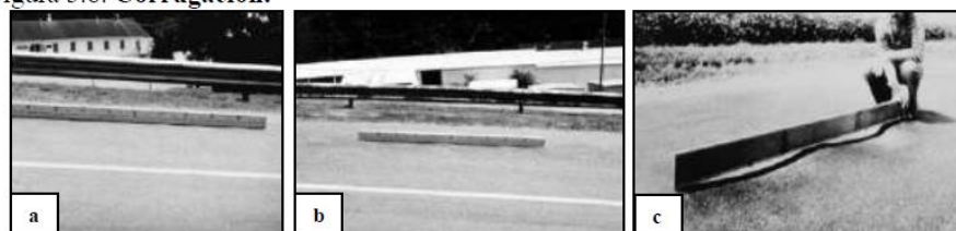
Figura 26. Corrugación de nivel de severidad bajo (a), medio (b) y alto (c).
