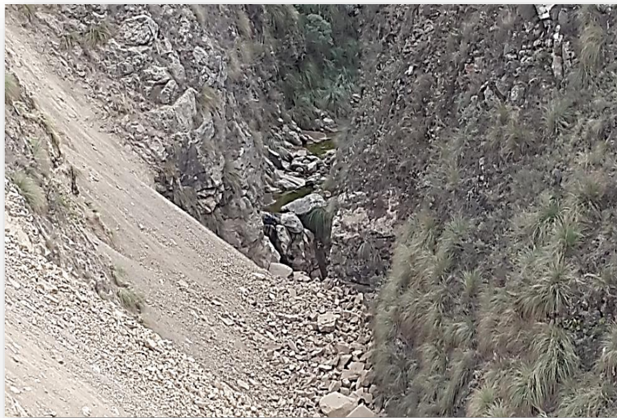
FIGURA N° 41 curso de agua bloqueado por la presencia de material de corte
