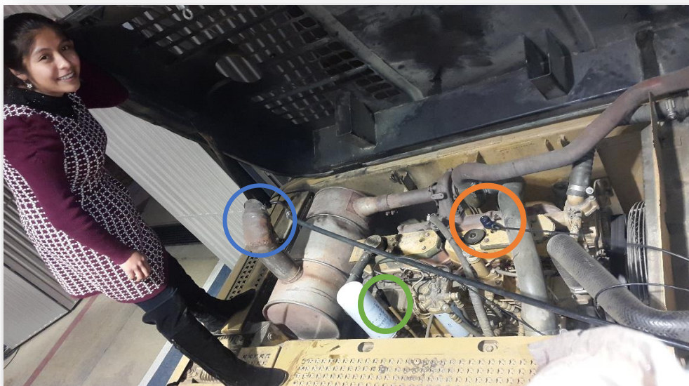
FIGURA N° 32 Instalación de las sondas de medición
