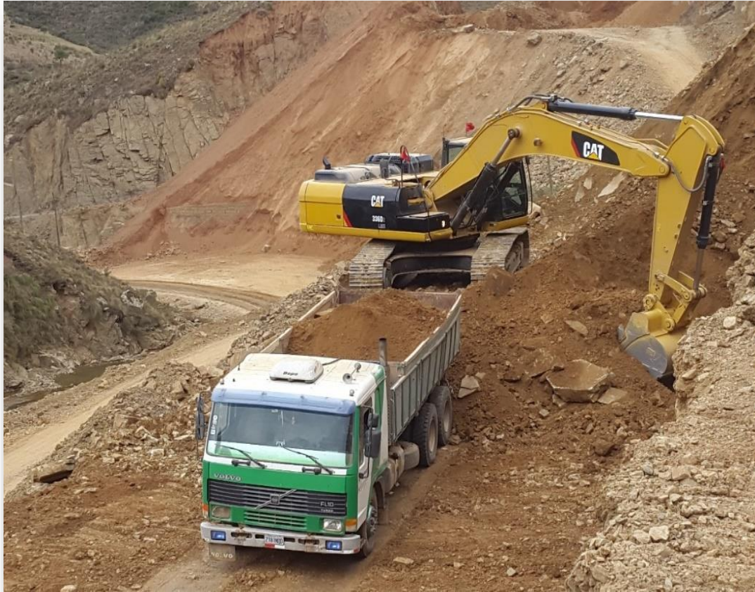
FIGURA N° 19 Excavadora Caterpillar modelo 336-D2L trabajando en el movimiento de tierras
