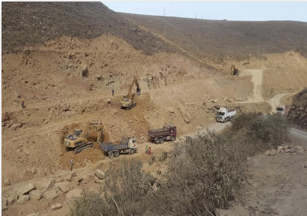
FIGURA N° 16 Maquinaria pesada trabajando en el movimiento de tierras
