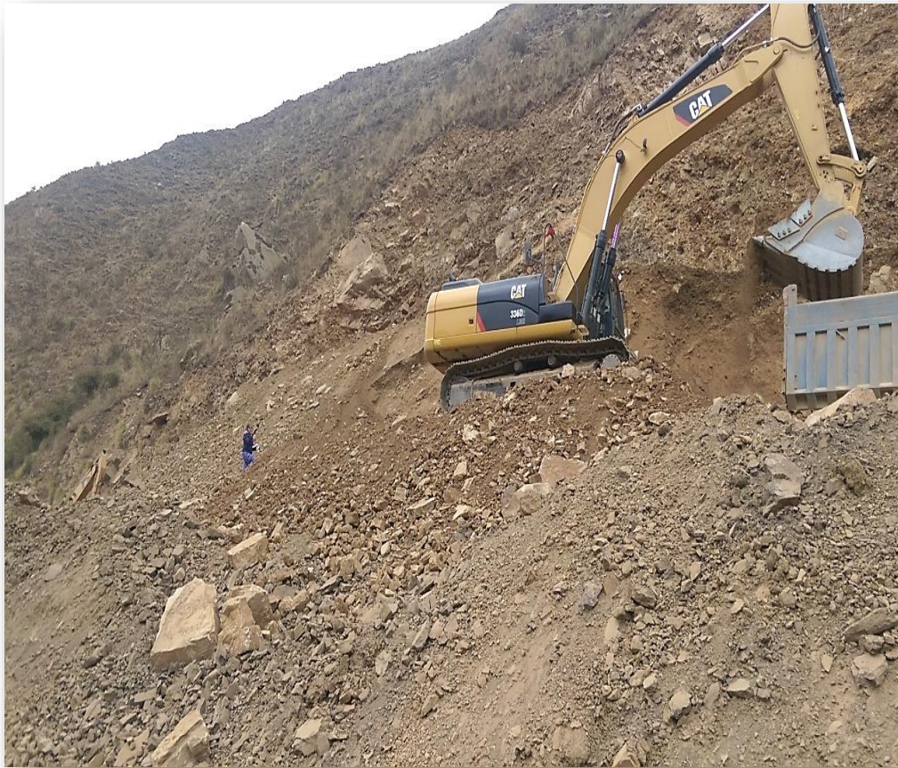
FIGURA N° 20 Medición de ruido en la excavadora modelo 336-D2L
