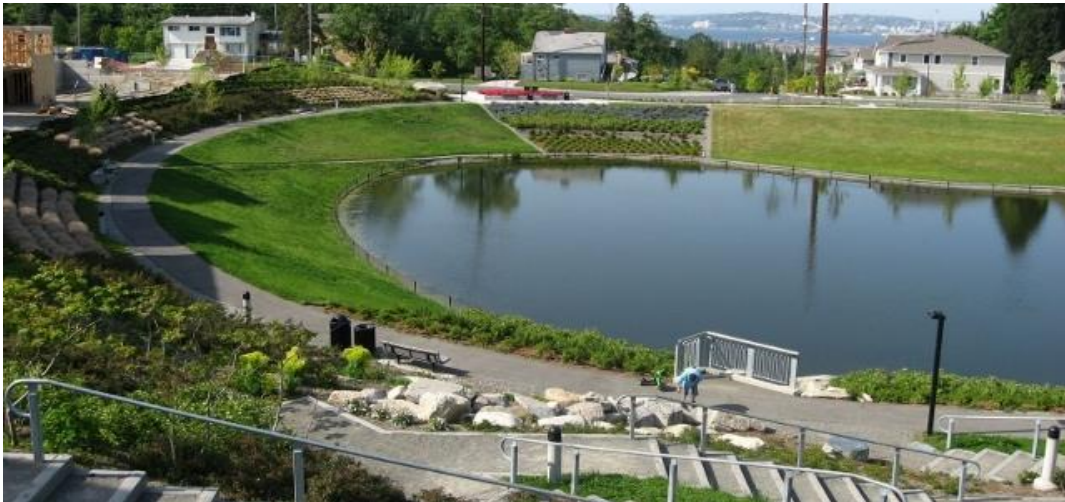
Imagen 13. Estanque de retención en área residencial de Seattle (USA).
