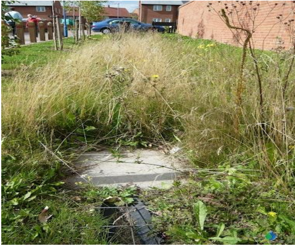
Detalle de cuneta verde en zona urbana. Fuente: Susdrain
