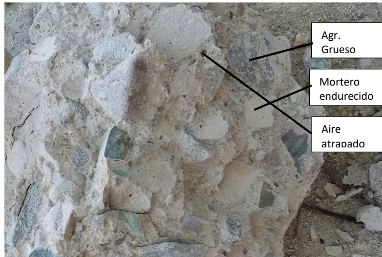
Fotografía N°1. Hormigón endurecido mostrando las partes que lo componen
