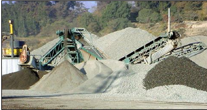
Fotografía N°19. Planta seleccionadora de áridos.
