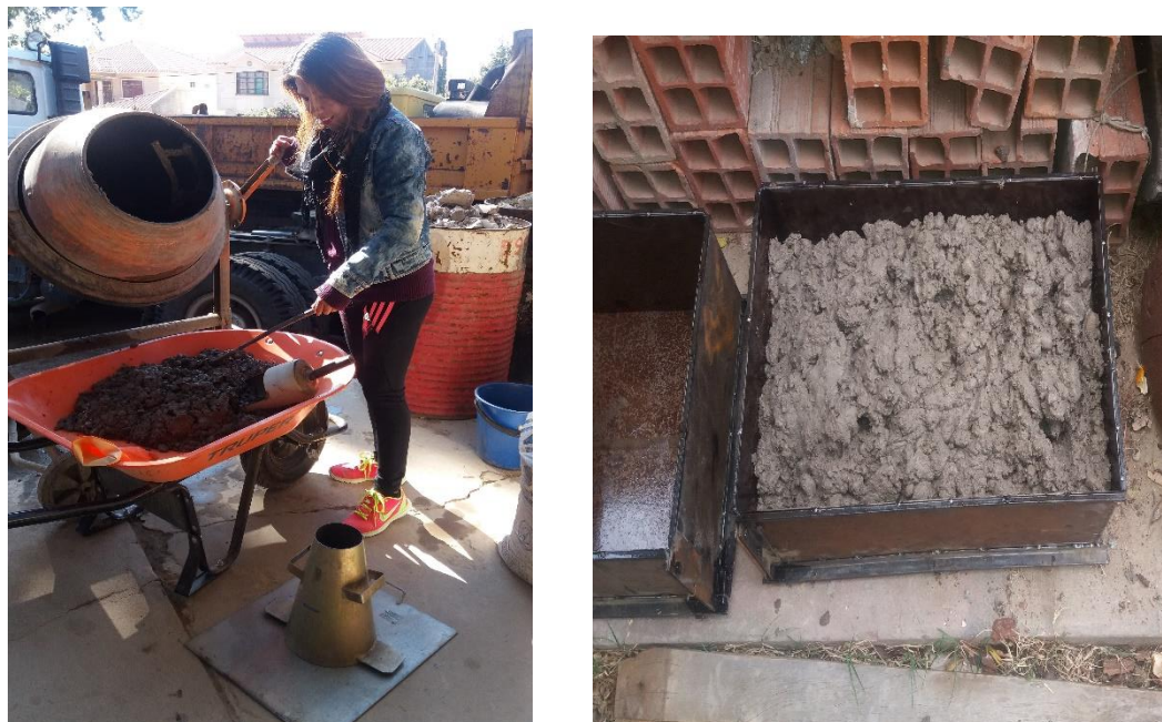
Figura 4.30. Elaboración del hormigón y vaciado
