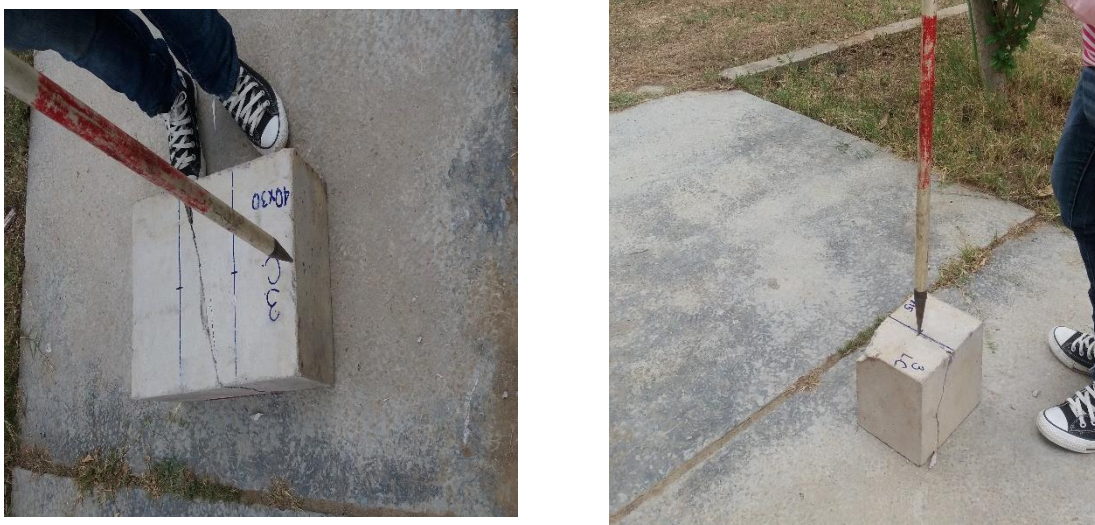
Figura 4.41. Medición de las cotas en las losas
