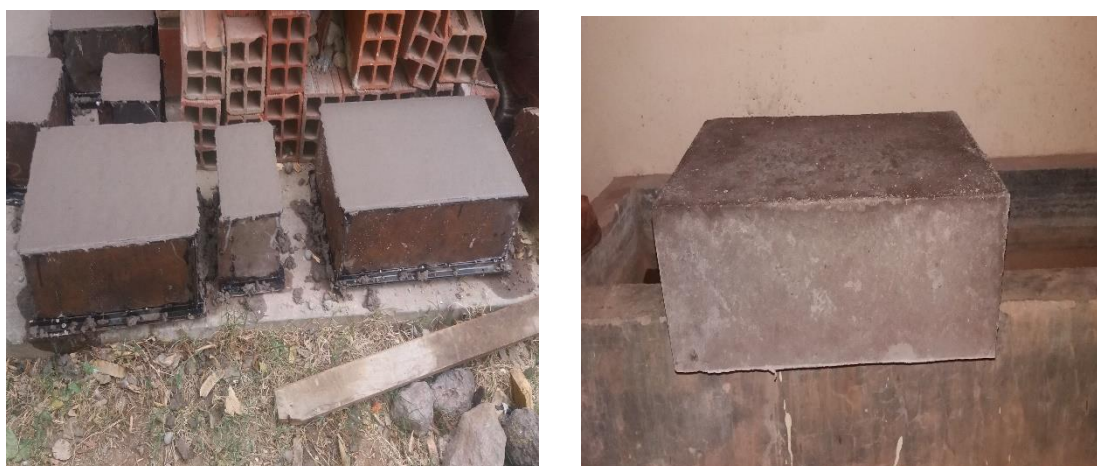
Figura 4.31. Enrasado y desmolde de la losa
