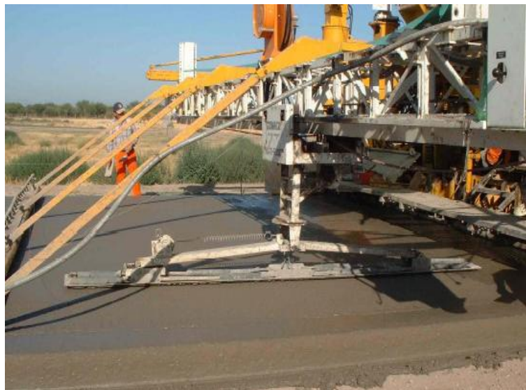
Figura 17: Operación de la Regla
