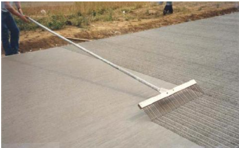
Figura 18: Operación de la Texturizado Final Mediante Cepillos
