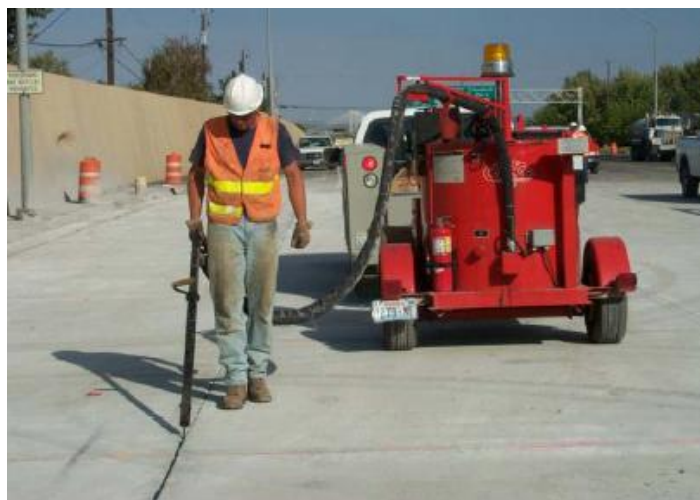
Figura 23: Operación Sello de Juntas
