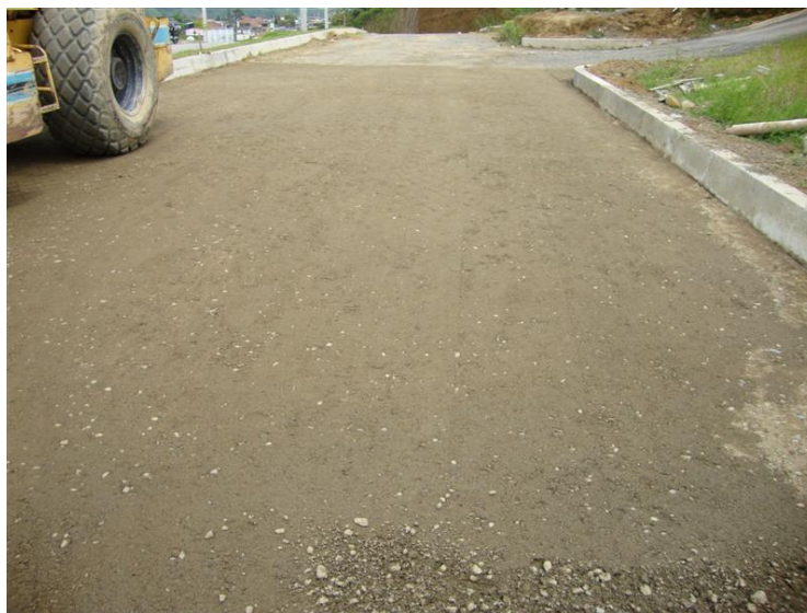
Figura 16: Acabado y Compactado de la Capa
