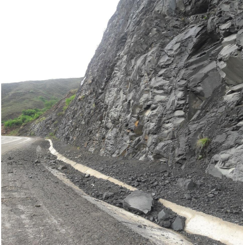
Fig. 4.2 Material Talud N° 1
