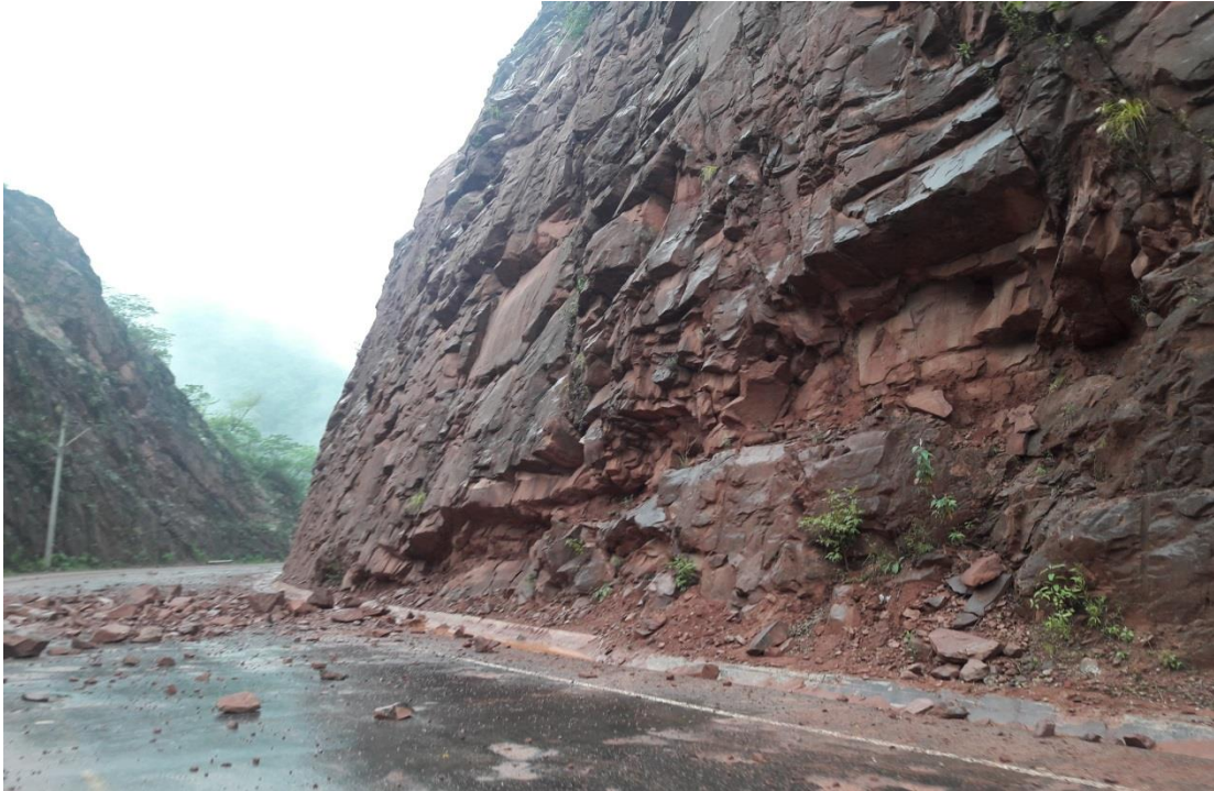
Fig. 4.10 Material Talud N° 9
