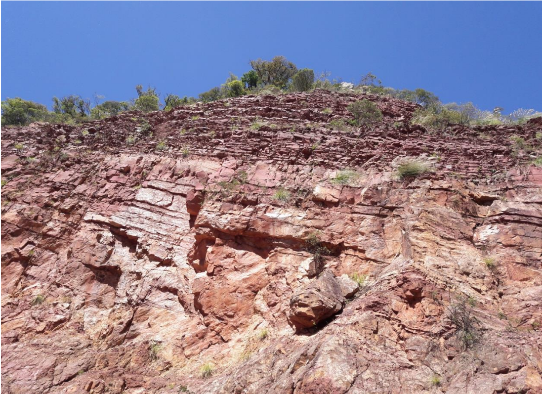
Fig. 4.5 Material Talud N° 4
