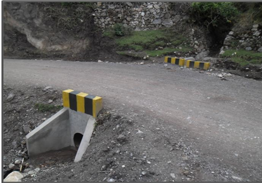
Fig. 2.6 Elementos de Drenaje
