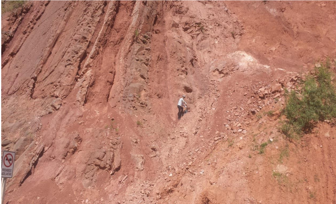
Fig. 4.8 Material Talud N° 7
