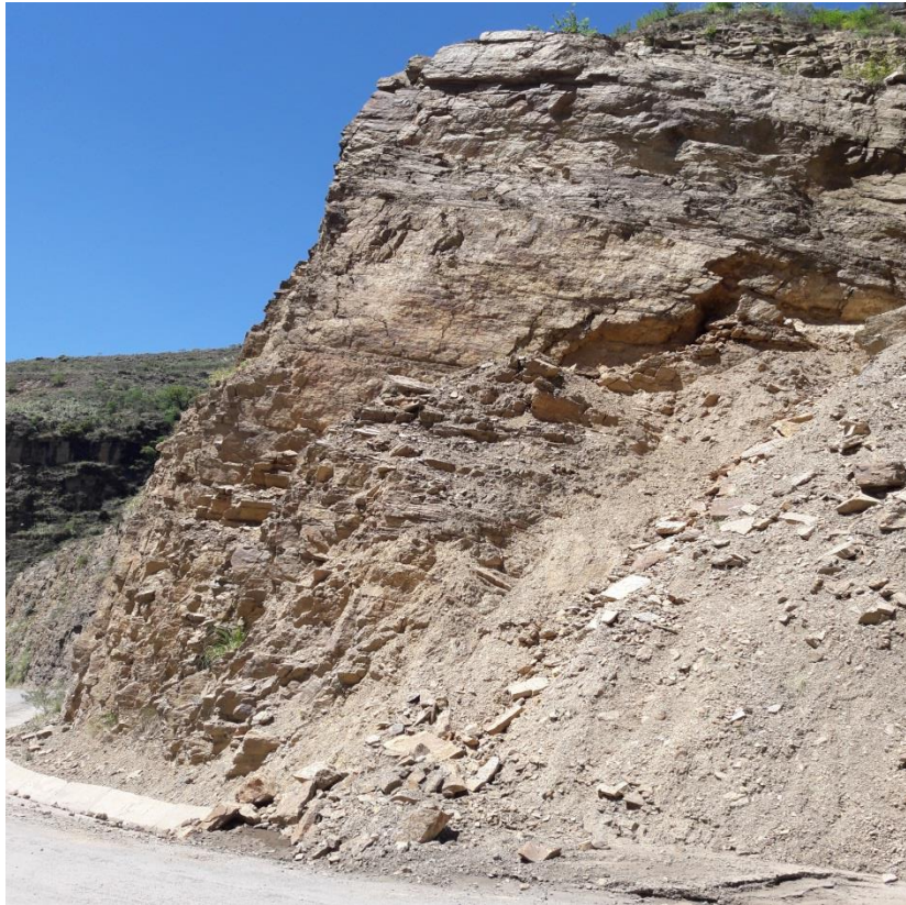
Fig. 4.3 Material Talud N° 2
