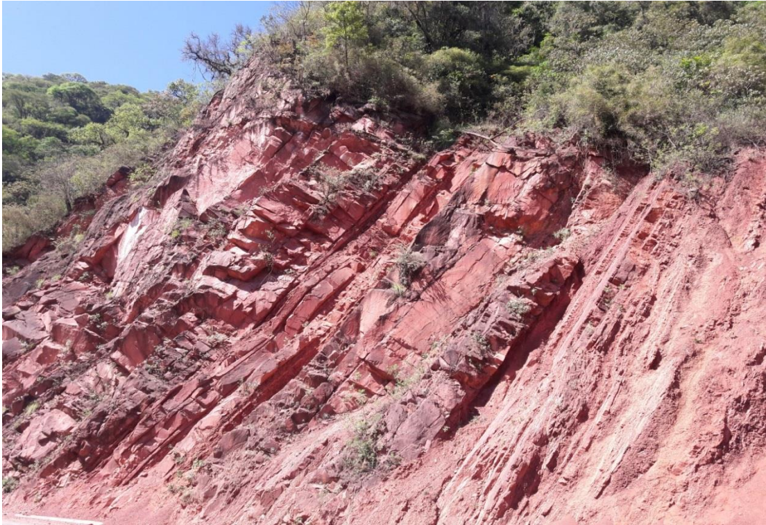
Fig. 4.9 Material Talud N° 8
