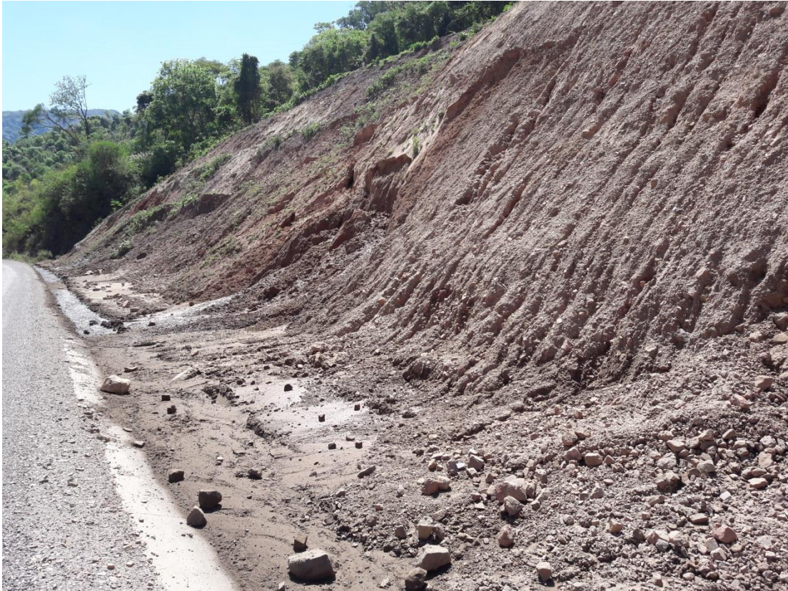
Fig. 4.6 Material Talud N° 5
