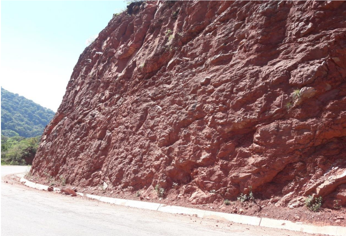
Fig. 4.7 Material Talud N° 6
