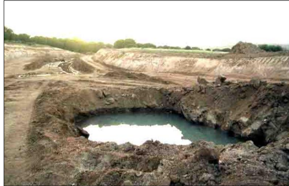
Figura N° 2.13. Caudal por abatimiento del nivel freático
