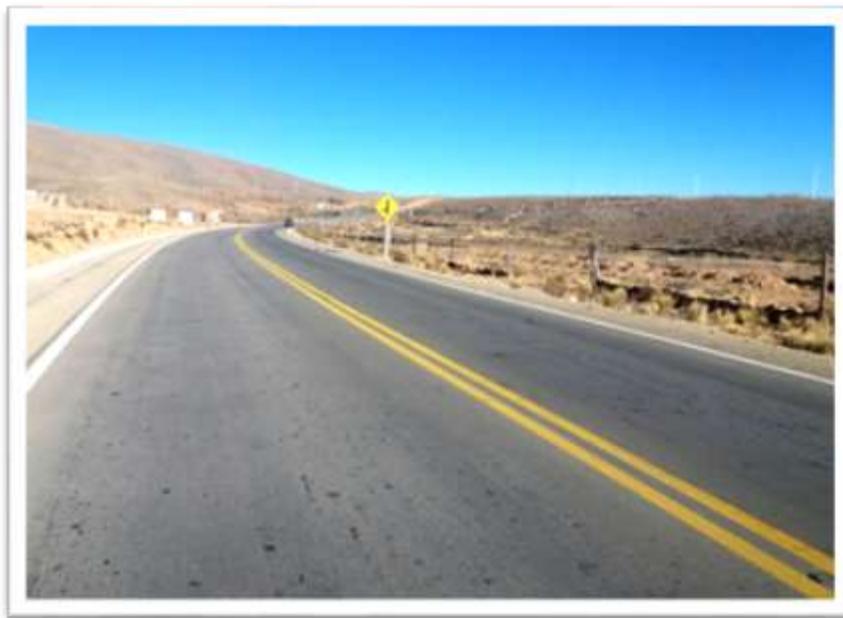
FIGURA 4. 3: TRAMO CARRETERO TÚNEL FALDA LA QUEÑUA – SAN LORENCITO
