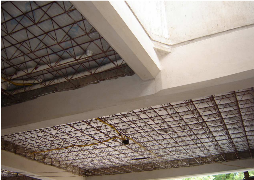
Foto 3. Edificio en construcción utilizando como entrepiso la tridilosa
