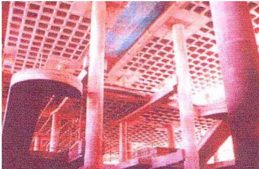
Foto 2. Centro comercial en construcción utilizando forjados reticulares con casetones recuperables
