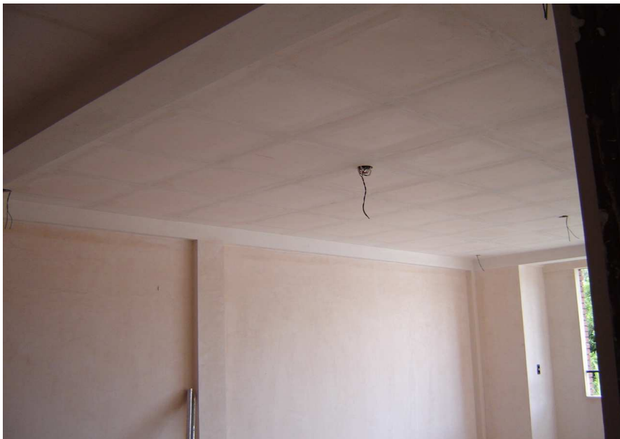
Foto 4. Edificio en construcción con entrepiso de tridilosa y cielo falso con placas de yeso
