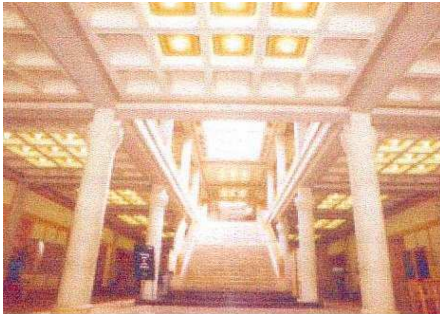
Foto 1. Museo y biblioteca utilizando forjados reticulares apoyado en vigas con casetones recuperables
