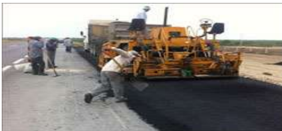
Figura 2.5: Maquina de Pavimentación.
