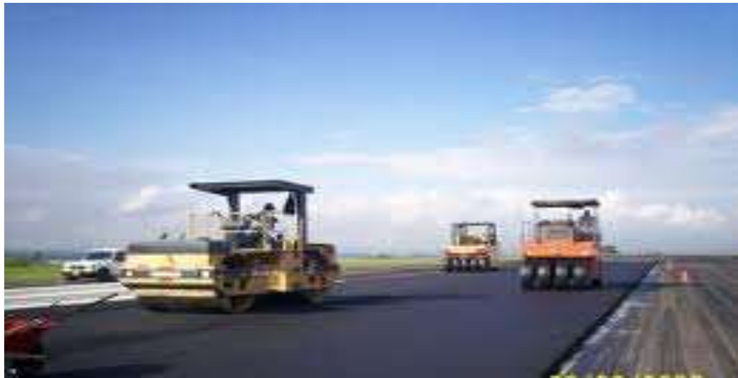
Figura 2.6: Compactación de la Carpeta Asfáltica.
