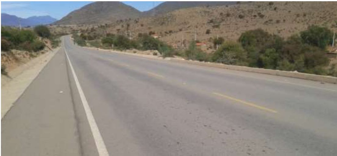
Figura 2.1: Pavimento Flexible de la Carretera al Chaco
