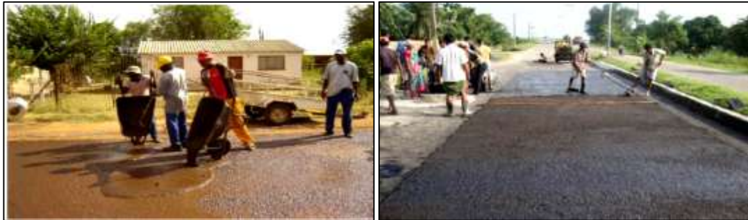
Figura 2.28: Fabricación y Aplicación Manual de Micro Superficies Asfálticas.
