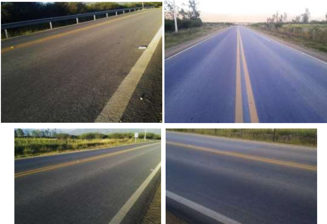
Figura 5.3. Características Actuales (2017) de la Capa de Rodadura con Micro Superficies.
