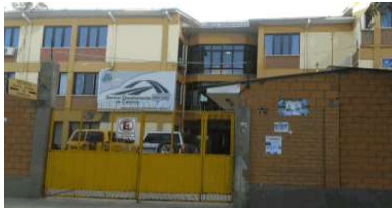
Fig. 3.10: Edificio del Servicio Departamental de Caminos de Tarija
