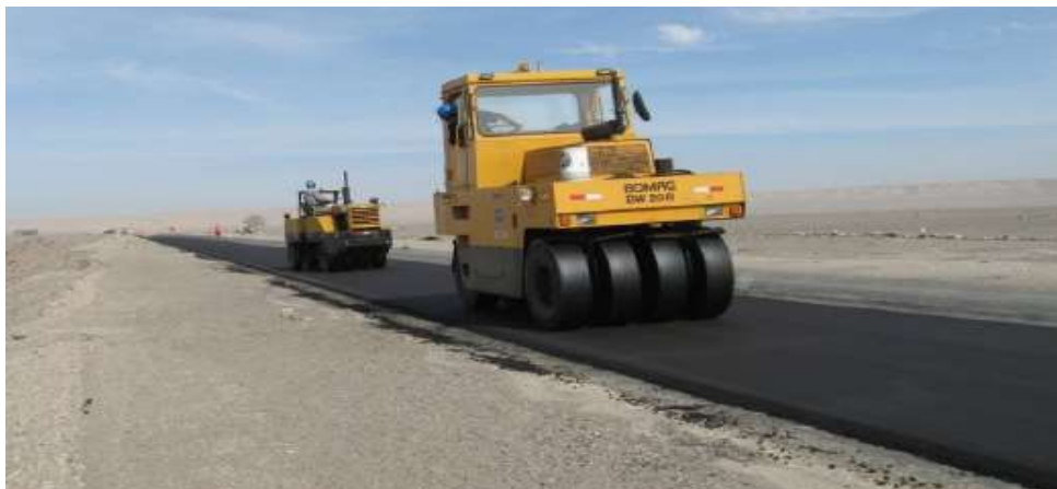
Figura 2.29: Compactación de la Micro Superficie.
