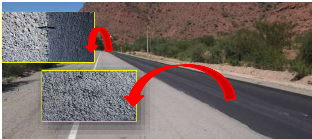
Figura 2.30: Aspecto al Final del Proceso de Fraguado de la Micro Superficie.
