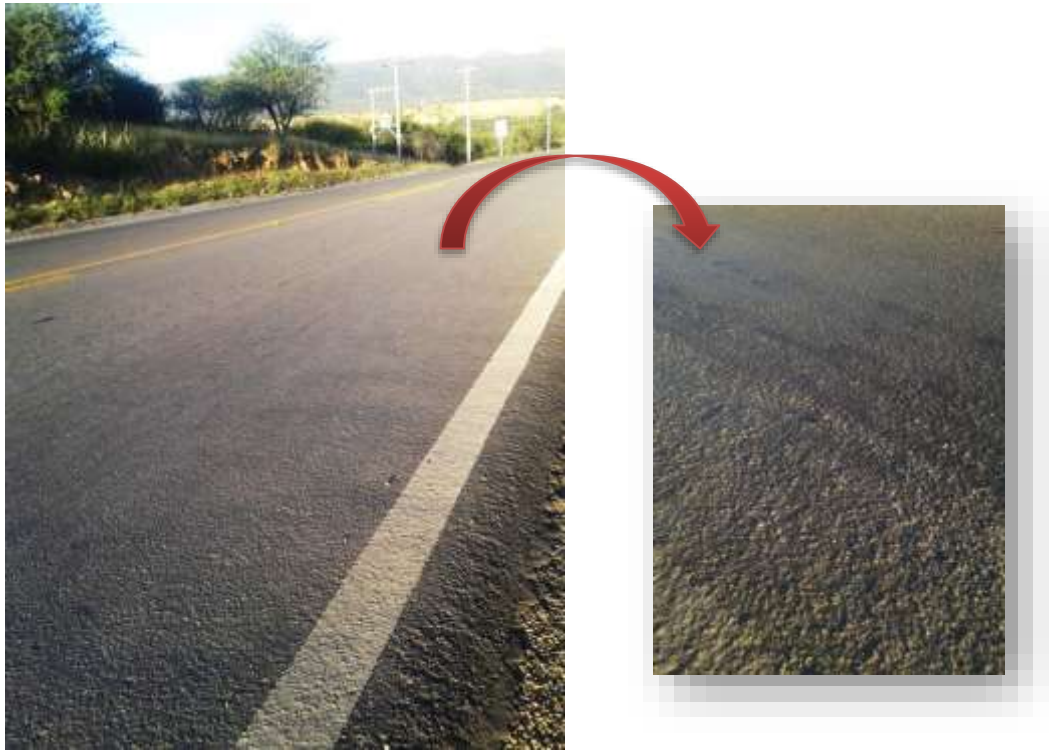
Figura 5.3. Características Actuales (2017) de la Capa de Rodadura con Micro Superficies.
