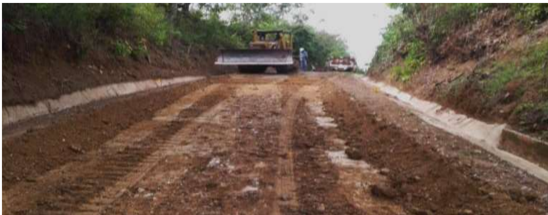
Figura 2.3: Excavación de la Sub Rasante.
