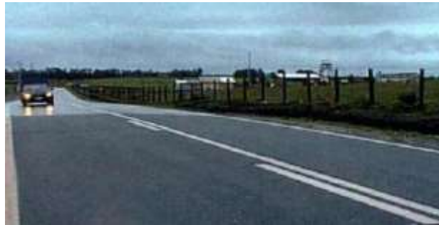
Fig. 2.1 Pavimento en buen estado
